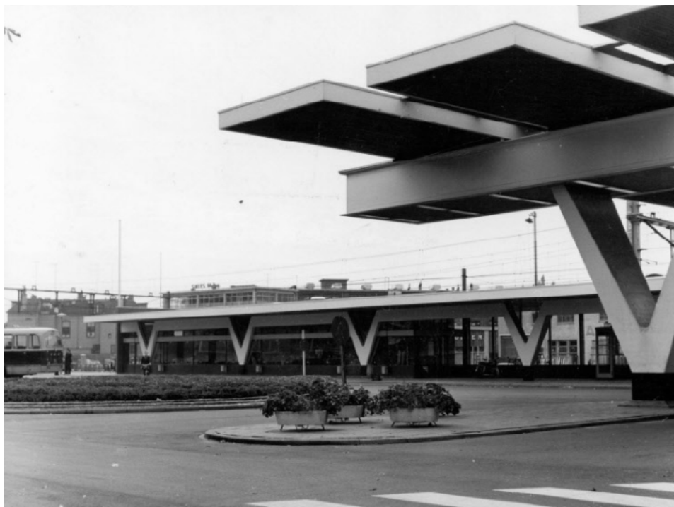
Verlichting in de doorlopende onderslagbalk
