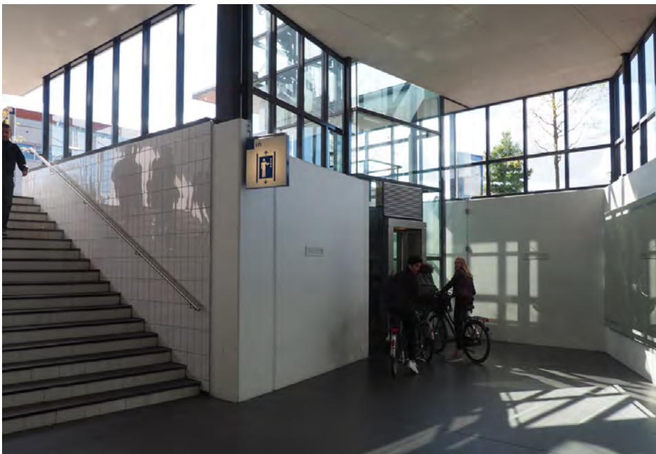
Achteruitgang met nieuw toegevoegde lift
