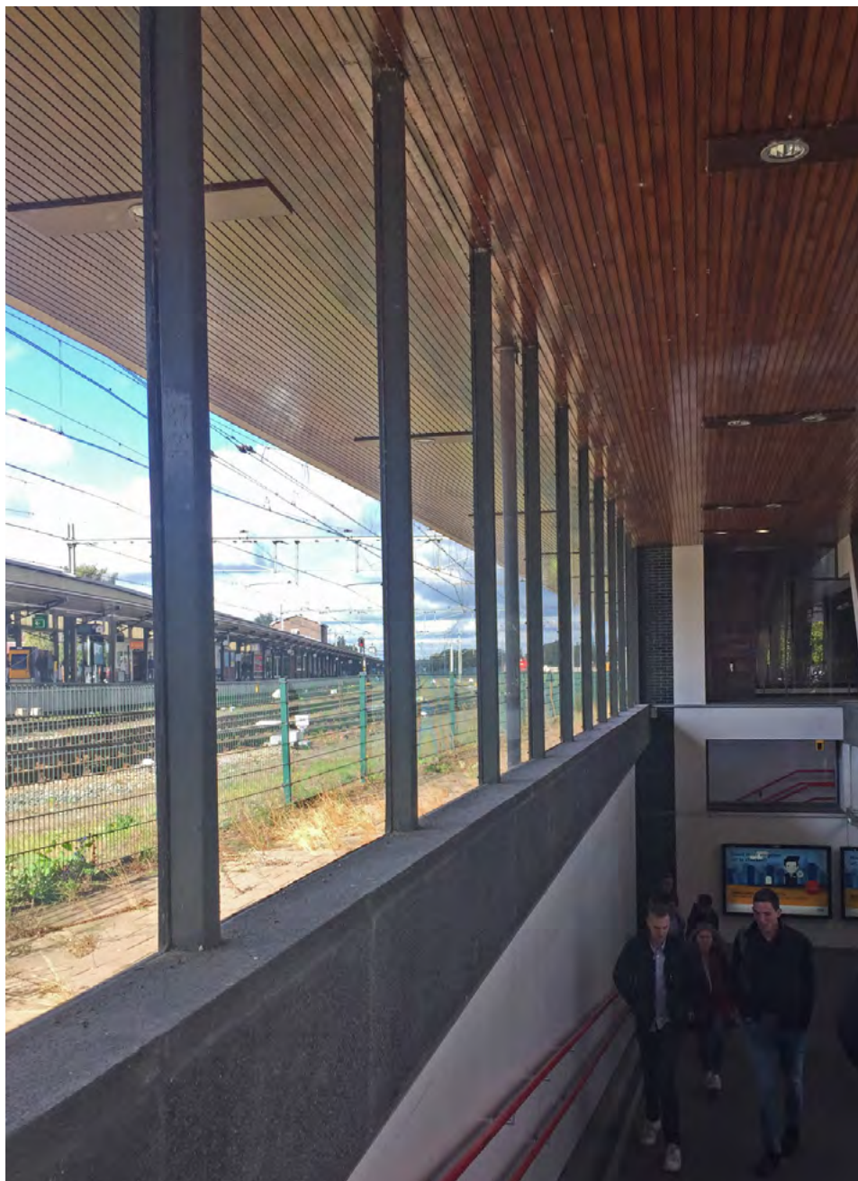
Oorspronkelijke gelakte schrotenplafonds
