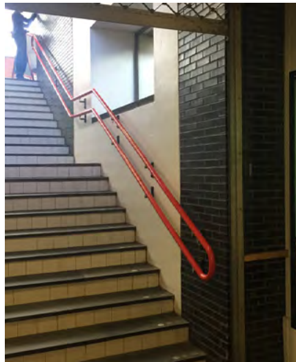
Restanten van het verglaasde, antraciete metselwerk van de toren
