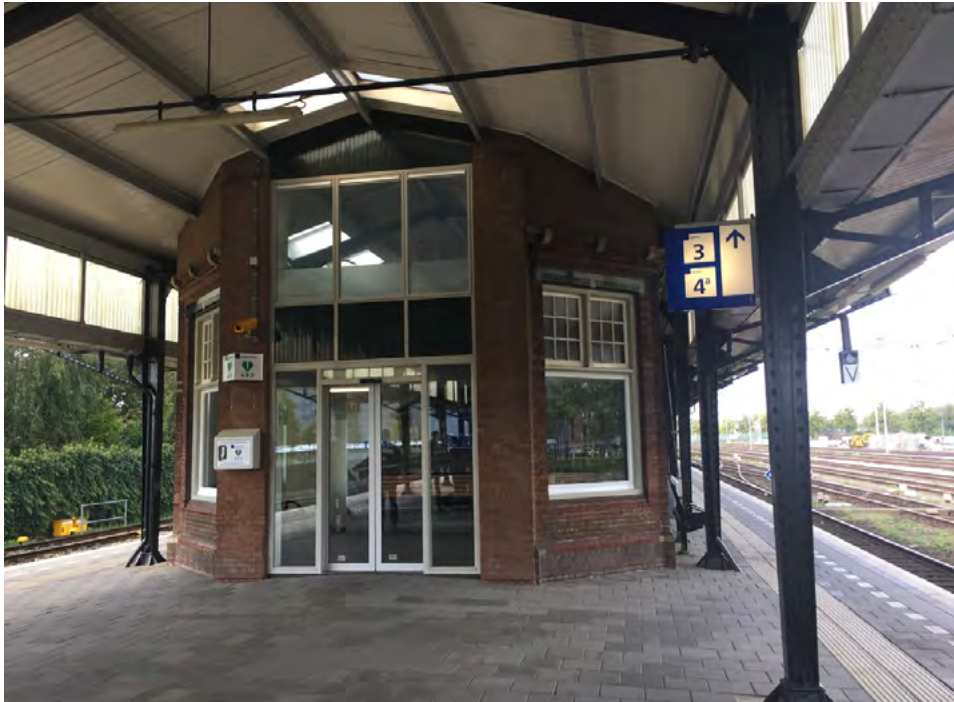
Kop perrongebouw, voorzijde
