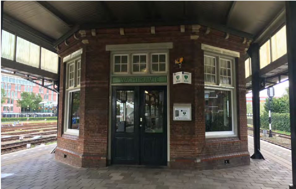
Kop perrongebouw, achterzijde
