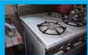
Artefacto cocina sin dispositivo de seguridad y llave de corte mal instalada
