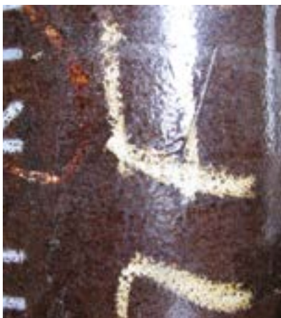
Korrodiertes Pipelinerohr API 5L Stahl
