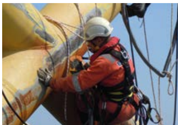
Bristle Blaster® auf einer Offshore-Plattform
