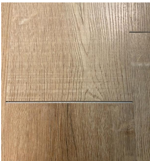
PRZYKŁAD ZAMONTOWANYCH PANELI NA ZŁYM PODŁOŻU
