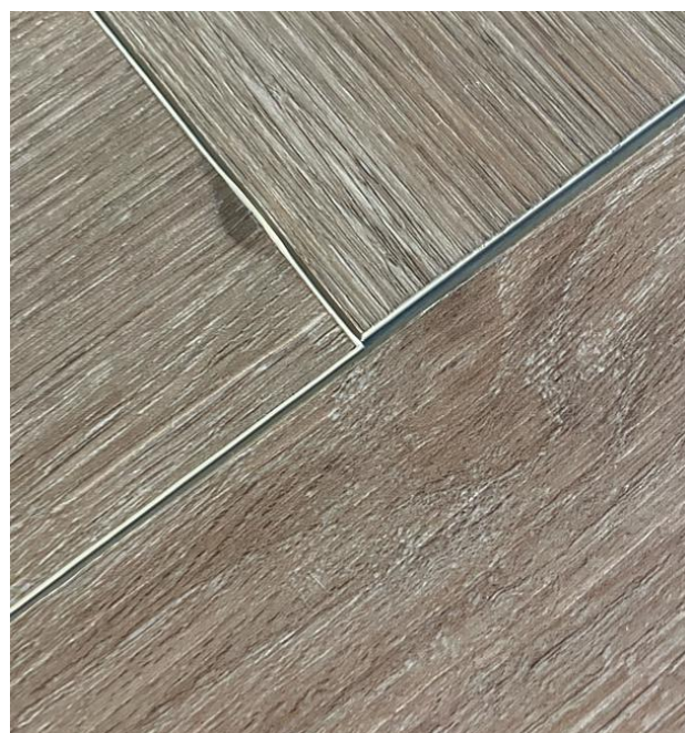
PRZYKŁAD ZAMONTOWANYCH PANELI NA ZŁYM PODŁOŻU
