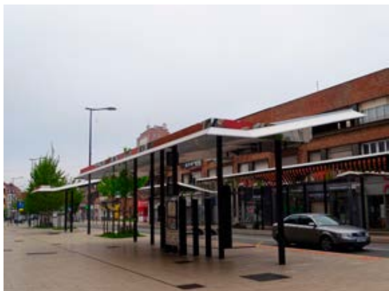
Dunkerque Centre-ville - auvents ventilés
