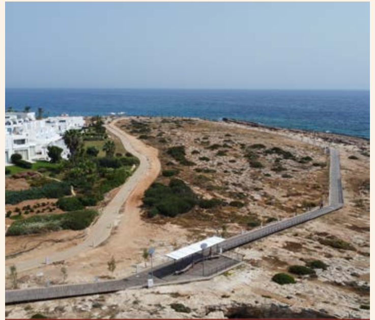
Γ' Φάση Παραλιακού Πεζόδρομου Κόστος: 5 εκατομμύρια ευρώ
