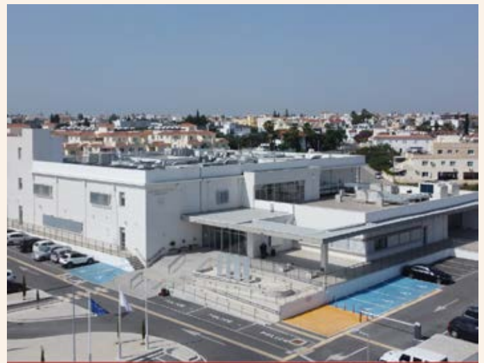
Επαρχιακό Δικαστήριο Αμμοχώστου Κόστος: 8 εκατομμύρια ευρώ
