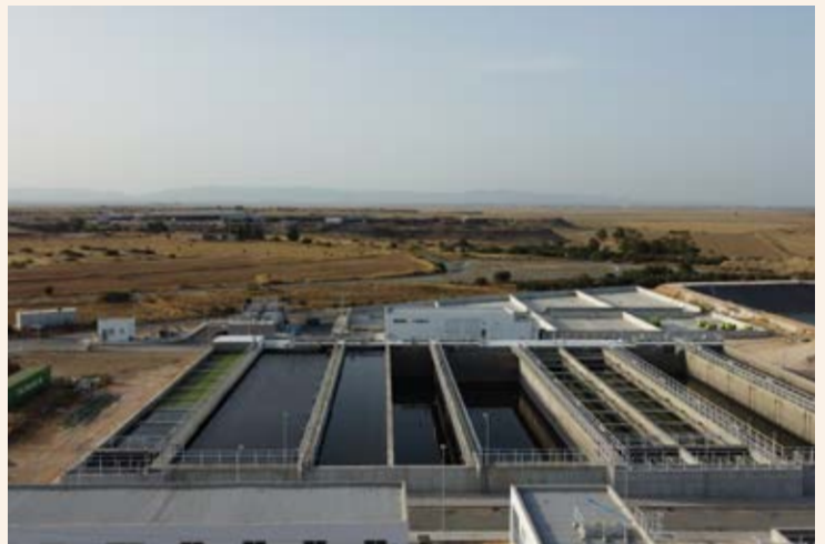
ΕΡΓΟΣΤΑΣΙΟ ΕΠΕΞΕΡΓΑΣΙΑΣ ΛΥΜΑΤΩΝ ΣΥΜΒΟΥΛΙΟΥ ΑΠΟΧΕΤΕΥΣΕΩΝ ΚΟΚΚΙΝΟΧΩΡΙΩΝ
