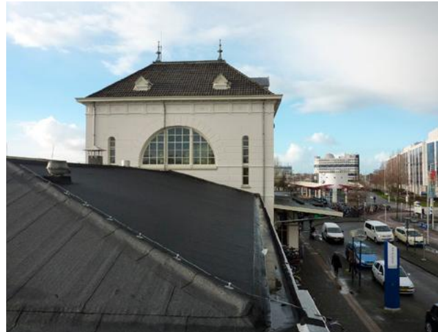
Dakkap oostvleugel bekleed met bitumen.
