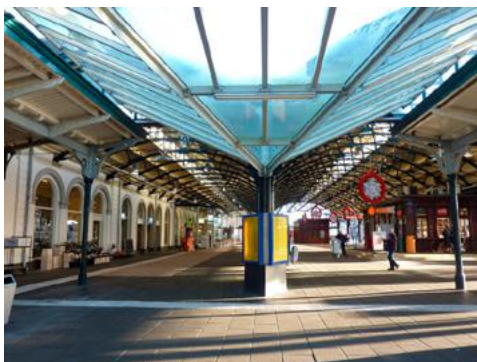
Een van de extra overdekkingen die boven de zaksproen zijn aangebracht.
