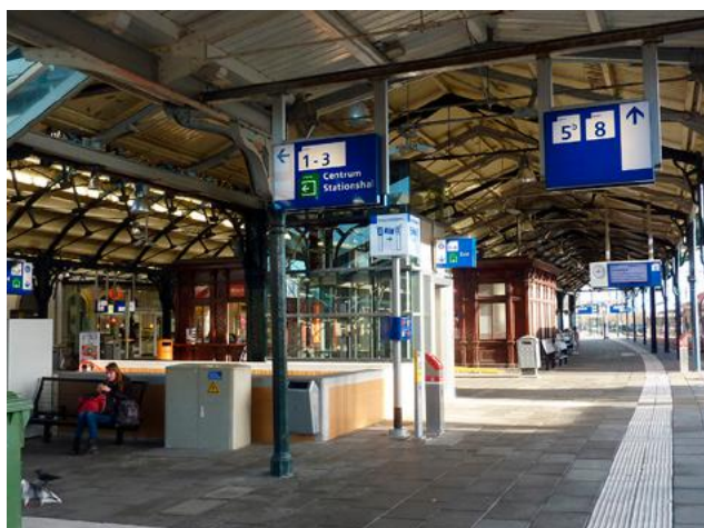
Trapombouw en lift naar de voetgangerstunnel in hoofdperron.
