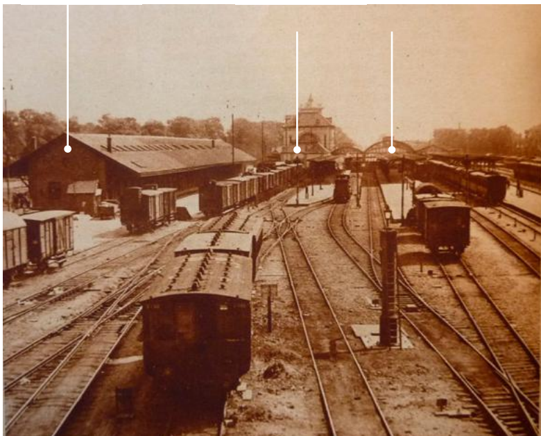
Gezicht op het emplacement gezien vanuit seinhuis B, omstreeks 1920. [HCL]
