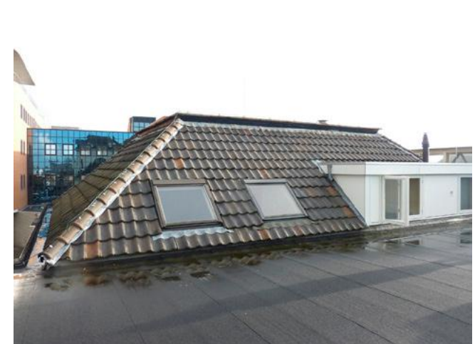
Dakkap uiteinde oostvleugel (voormalige woning restaurateur). Aan de perronzijde is een doorlopende dakkapel gebouwd.
