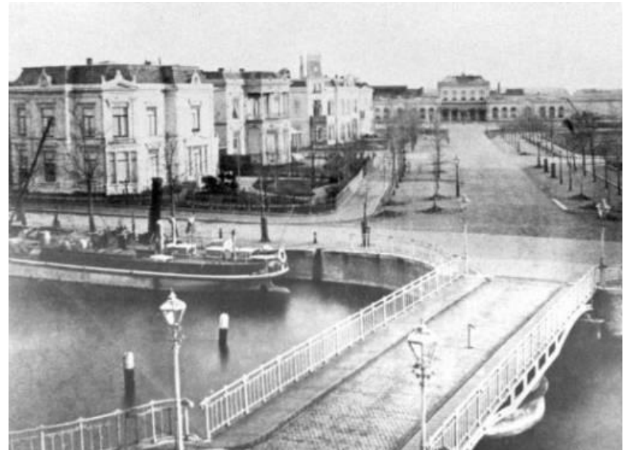
Het station gezien vanuit het noorden, omstreeks 1900. Langs de Sophialaan zijn de dubbele bomenrijen zichtbaar. [friesfotoarchief.nl]
