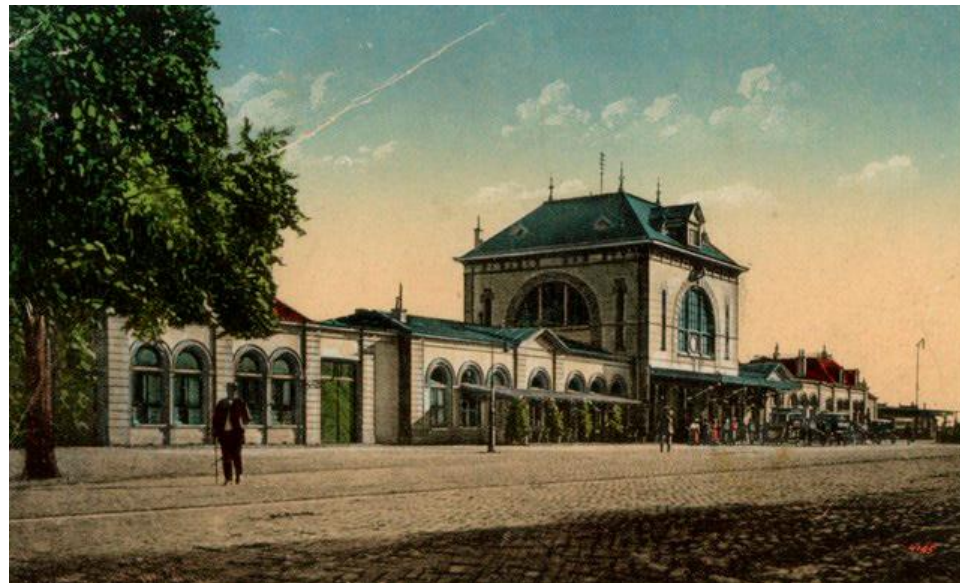
Zicht op het station na de verbouwing van 1904-1905. [Stationsweb]
