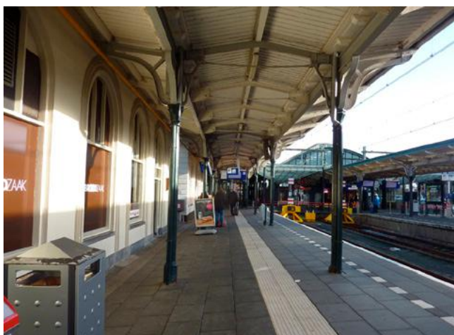
Verhoogd 1ste perron (zichtbaar aan het langzaam verdwijnen van het basement van de kolommen.
