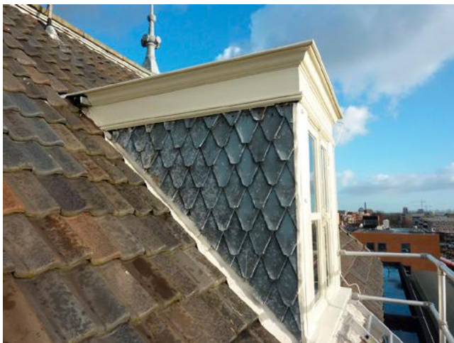
Oorspronkelijke dakkapel middendeel stationsgebouw (met zinkbeplating).
