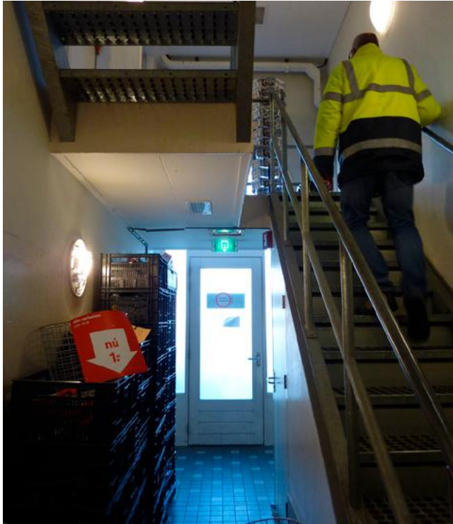
Nieuwe trap naar de zolder in de westvleugel (tussen de Etos en de Bruna).
