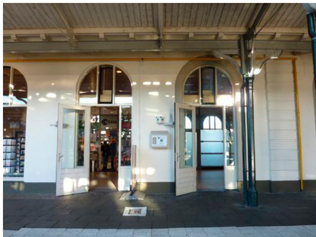
Achtergevel stationsgebouw te hoogte van de Etos.
