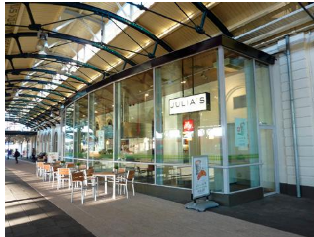
Uitbouw Julia's aan de achterzijde van het stationsgebouw.
