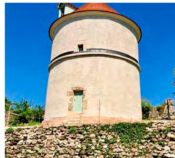
Les travaux de restauration du pigeonnier d'Andecy se sont achevés en 2025. © DR
