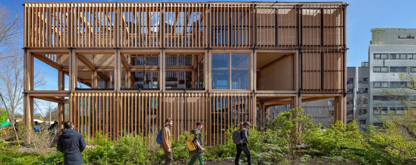
De houten lamellen waren zonnewarmte The Natural Pavilion, DP6
