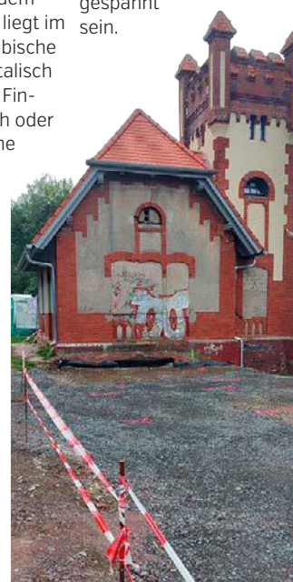
ALLES ROT-WEISS Der Ausbau des alten Schöpfwerks „Mäuseburg“ in den Prester Elbwiesen ist fertig, die Fläche für den künftigen Anbau ist bereits geplant
