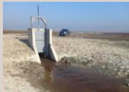
Hat zsilip épült újjá, és egy teljesen új zsilip is készült a Büdösszéki-csatornába becsatlakozó Vesszősi-csatorna torkolatánál (fotó: Pataki Zsolt)
