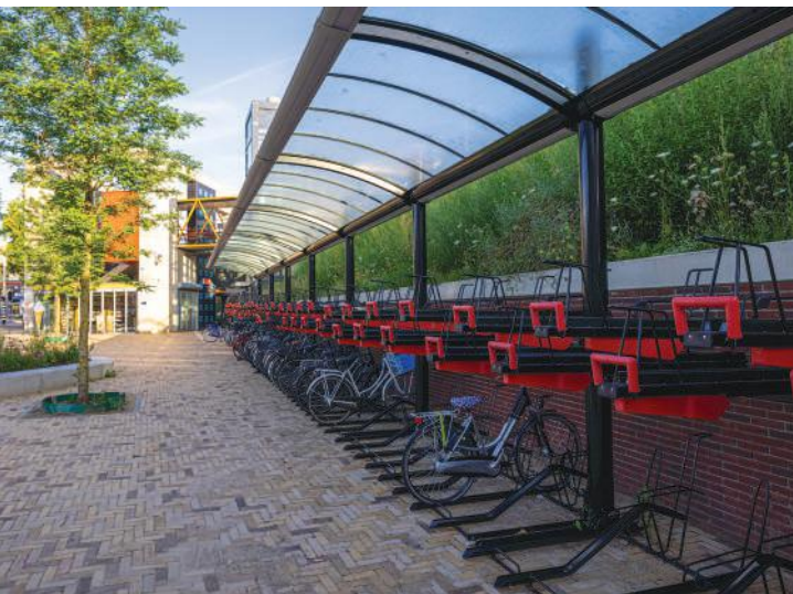
Fietsenstalling bij station Arnhem Velperpoort
