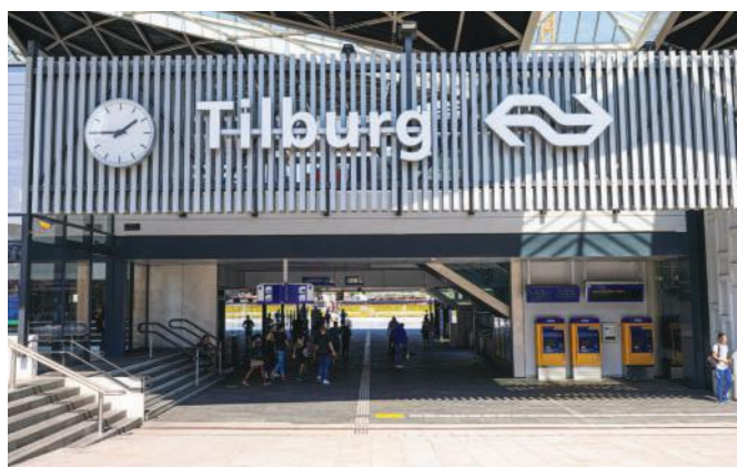
Reisinformatie en kaartverkoop rechts van de entree Station Tilburg
