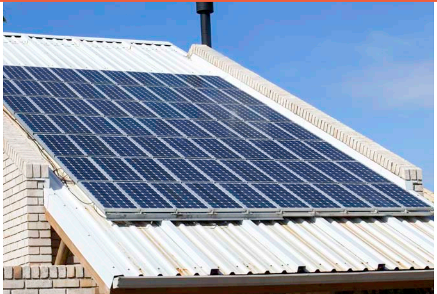
Placas utilizadas para captar energia solar e transformá-la em eletricidades
