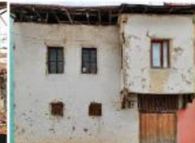
Adres : 5. Sk. No: 22 Parcel No: 1988 Kat Sayısı: 2 Yapım Sistemi: Yiğme Kagir Yapı Malzemesi: Kirepiç Çatı Türü: Beşik Çatı Çatı Malzemesi: Ahşap , Alderli Kiremit Çeşitli Elemanlar: Ahşap pencere , Ahşap Kapı , Çimbe , Demir Korkuluk , Kirepiç asma , Dekoratif Panosu , Kirepiç Boya
