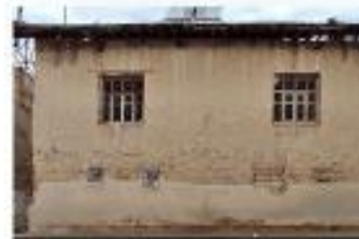
Adres : Çınar Sk. No: 24 Parafel No: 1990 Köt. Sayısı : 2 Yapım Süresi: İhtiya Kalgı Yapı Malzemesi: Kerpiç Çatı Türü: Başık Çatı Çatı Malzemesi: Ahşap , Adirizli Kiremit Çevre Elemanları: Kapı pencere , Demir korkuluk , Beton s İkbaliler , Elektrik panosu , Hayvan otla elemanı , Kerpiç ar
