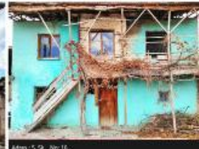
Adres : 5. Sk. No: 10 Parcel No: 1986 Kat Sayısı: 2 Yapım Sistemi: Yiğme Kagir Yapı Malzemesi: Kirepiç Çatı Türü: Beşik Çatı Çatı Malzemesi: Ahşap , Alderli Kiremit Çeşitli Elemanlar: Ahşap pencere , Ahşap Kapı , Ahşap Merdiven , Lüleba , Demir Korkuluk , Kirepiç asma , Boya
