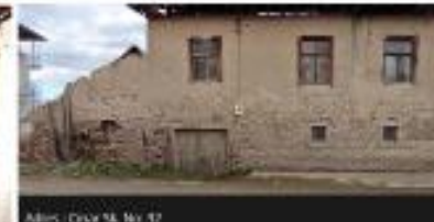
Adres : Çınar Sk. No: 37 Parcel No: 1984 Kat Sayısı: 2 Yapım Sistemi: Yiğme Kagir Yapı Malzemesi: Kirepiç Çatı Türü: Beşik Çatı Çatı Malzemesi: Ahşap , Alderli Kiremit Çeşitli Elemanlar: Ahşap pencere , Ahşap Kapı , Demir Korkuluk , Kirepiç asma , Dekoratif Panosu.
