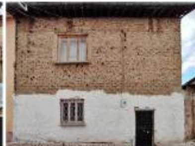
Adres : 5. Sk. No: 3 Parcel No: 1984 Kat Sayısı: 2 Yapım Sistemi: Yiğme Kagir Yapı Malzemesi: Kirepiç Çatı Türü: Beşik Çatı Çatı Malzemesi: Ahşap , Alderli Kiremit , Sac İbrik Çeşitli Elemanlar: Ahşap pencere , Demir Kapı , Demir Korkuluk , Kirepiç asma , Kirepiç Boya , Dekoratif Panosu
