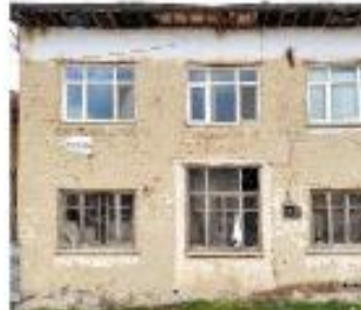
Adres : Çınar Sk. No: 44 Parafel No: 1990 Köt. Sayısı : 2 Yapım Süresi: İhtiya Kalgı Çatı Türü: Başık Çatı Çatı Malzemesi: Ahşap , Adirizli Kiremit , Sac naklı Çevre Elemanları: Kapı pencere , PVC Pencere , Dışarı Kır Kerpiç sıva , Elektrik Panosu , Kireç tozu .
