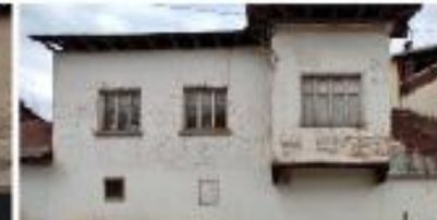
Adres : Çınar Sk. No: 38 Parcel No: 2987 Kat Sayısı: 2 Yapım Sistemi: Yiğme Kagir Yapı Malzemesi: Kirepiç Çatı Türü: Kemur Çatı Çatı Malzemesi: Ahşap , Alderli Kiremit Çeşitli Elemanlar: Ahşap pencere , Lüleba , Demir Korkuluk , Kirepiç asma , Dekoratif Panosu , Kirepiç Boya
