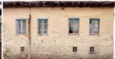
Adres : Çınar Sk. No: 41 Parcel No: 1985 Kat Sayısı: 2 Yapım Sistemi: Yiğme Kagir Yapı Malzemesi: Kirepiç Çatı Türü: Beşik Çatı Çatı Malzemesi: Ahşap , Alderli Kiremit Çeşitli Elemanlar: Ahşap pencere , Demir korkuluk , Kirepiç asma.
