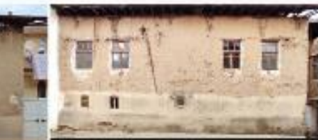
Adres : Çınar Sk. No: 25 Parcel No: 1949 Kat Sayısı: 2 Yapım Sistemi: Yiğme Kagir Yapı Malzemesi: Kirepiç Çatı Türü: Beşik Çatı Çatı Malzemesi: Ahşap , Alderli Kiremit Çeşitli Elemanlar: Ahşap pencere , Beton asma elemanlar , Kirepiç asma.
