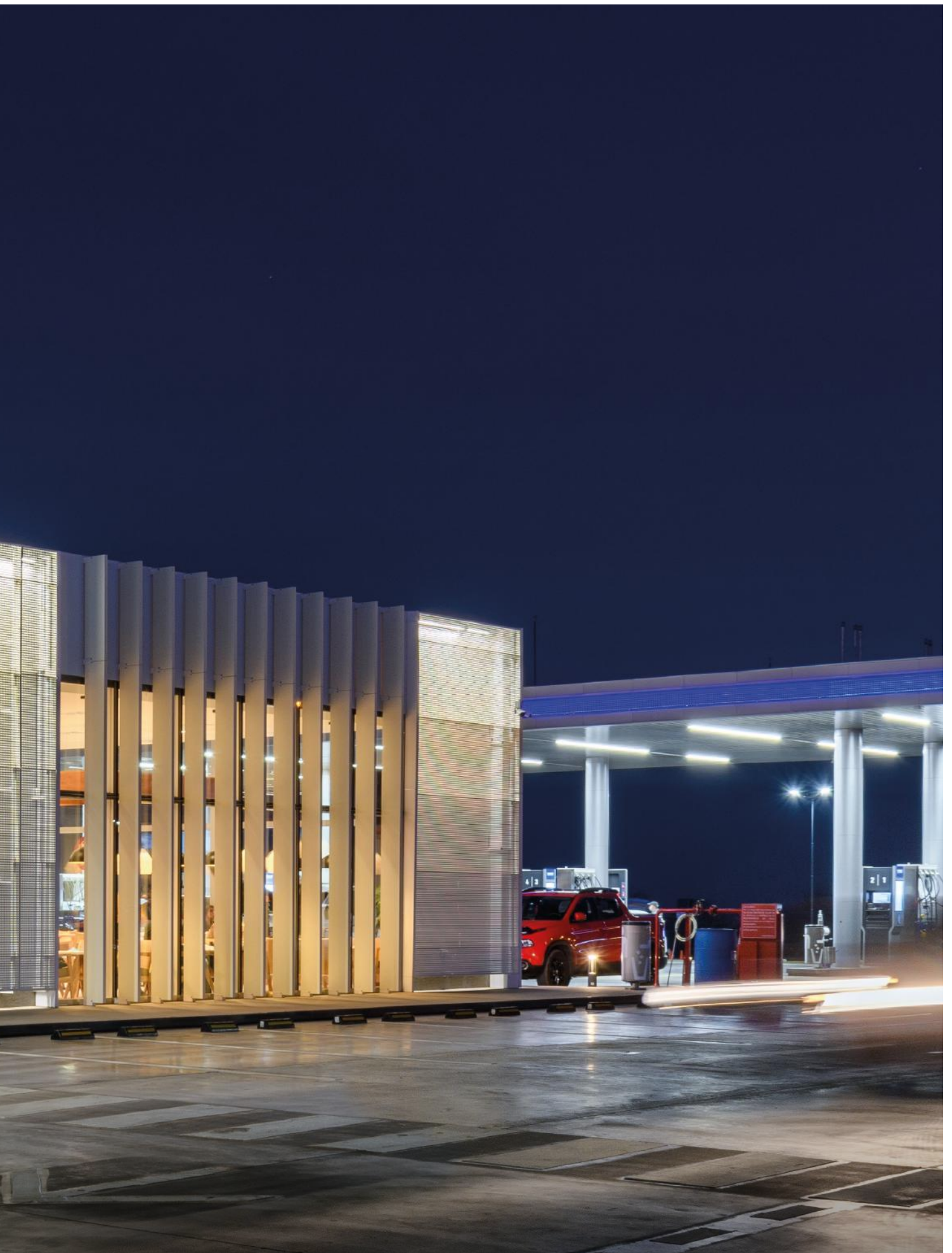
YPF E53 - Laprovitta Arquitectos - Córdoba
