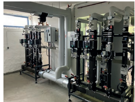
Modernisierte Hausanschlussstation
