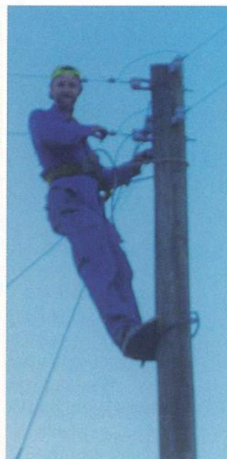
Freileitungsmonteur Meierhans, SUVA-konform gesichert.
