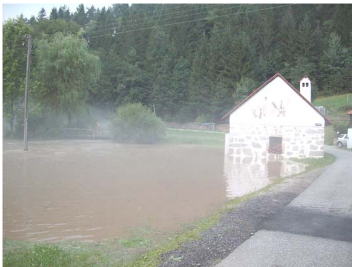
Hochwasser bei der Hammerschmiede - Naarntal
