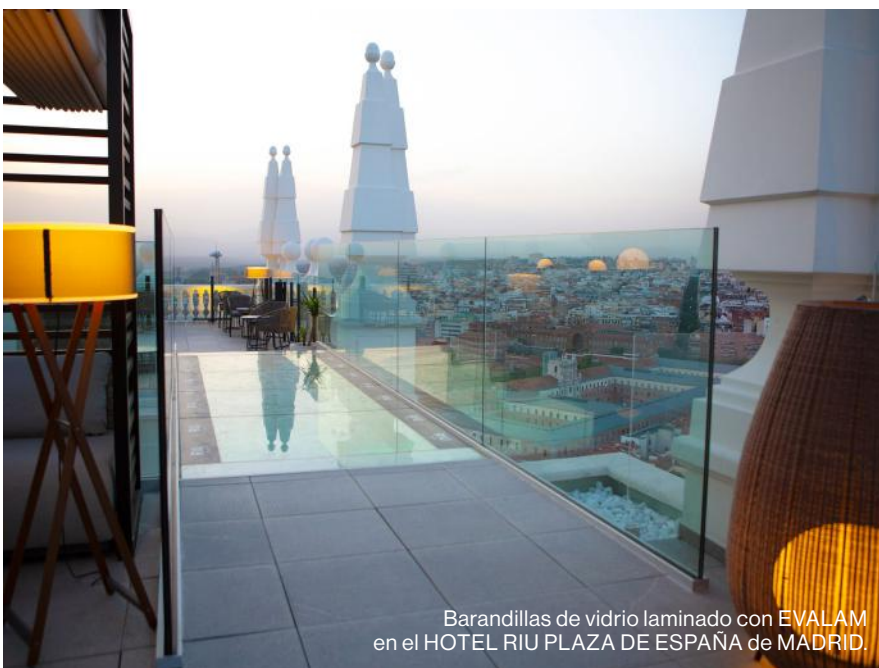
Ejemplo de uso de EVALAM en barandilla-muro de piscina.
