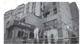
(Hình REUTERS: Một tòa nhà bị hư hại trong vụ tấn công bằng drone của Nga vào Kyiv.)
