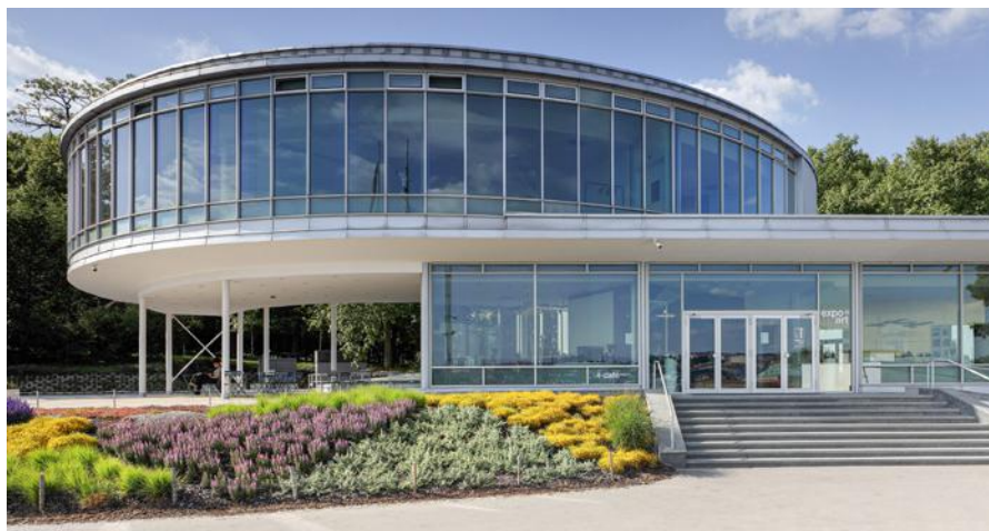
Vladimír Lekeš koupil Expo 58, nejvýznamnější stavbu poválečné moderní architektury v Československu, která vyhrála hlavní cenu (Grand prix) v roce 1958 na Světové výstavě v Bruselu. Tuto ikonickou budovu zrekonstruoval bez jakéhokoliv grantu a změnil na výstavní síň umění a galerii
