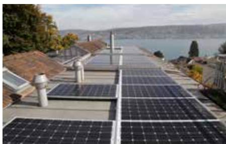
Blechfalzdach-Montage am Zürichsee.
