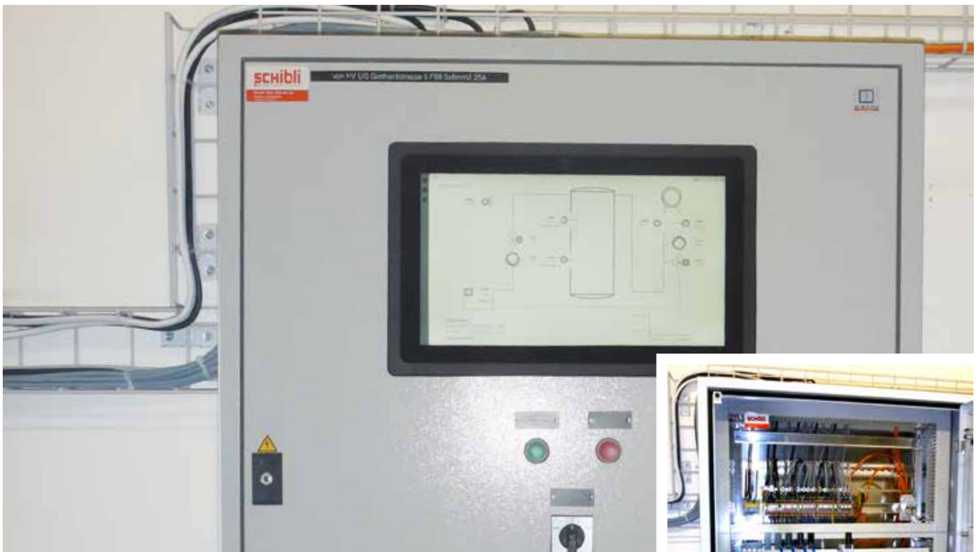
Aufnahmen der MSRL-Automationsstation mit der Bedien- und Beobachteinheit für das Gebäudeautomationssystem.
