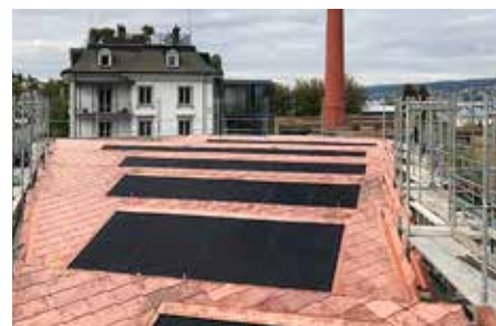
Kupfer-Stehdach mit integrierter Anlage am Zürichsee.
