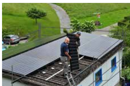
Aufdach-Anlage Ost-West auf Garagendach
