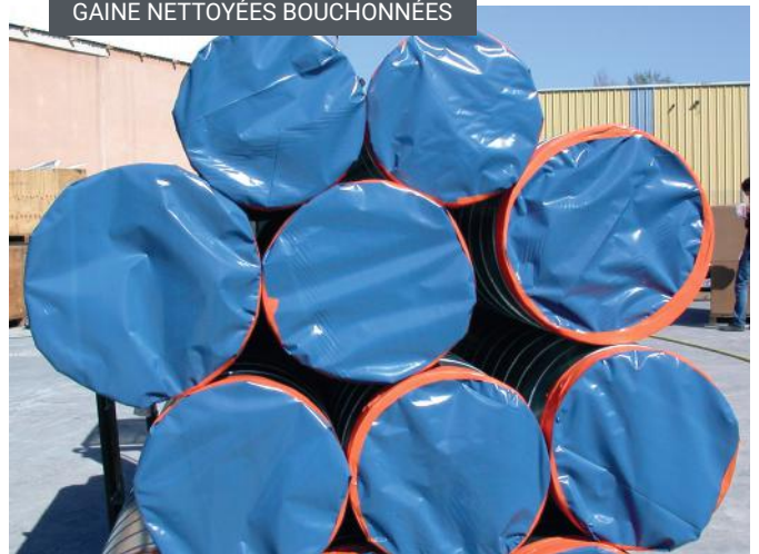
GAINE NETTOYÉES BOUCHONNÉES
