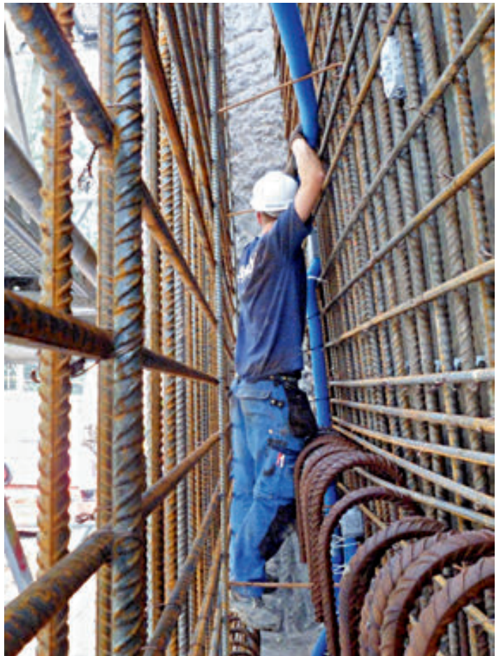
In der Vertikalen innerhalb der Elefantenarmierung sind nur schlanke Monteure fähig, Leerrohre einzubauen.
