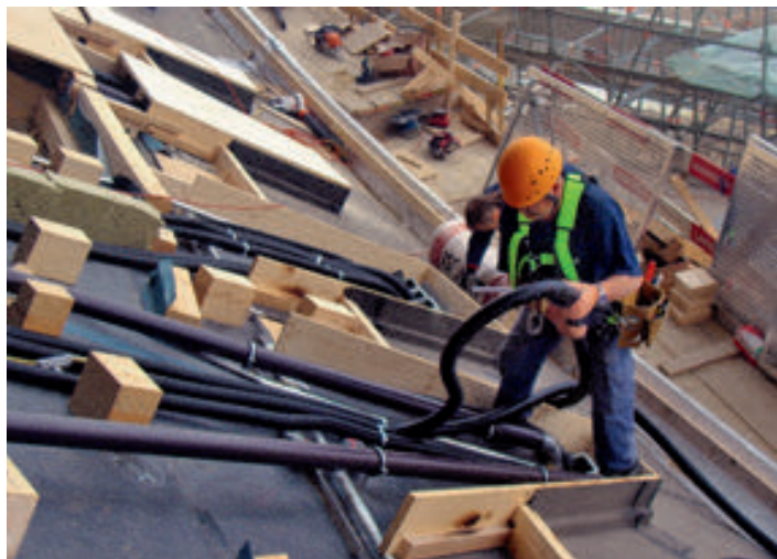
Installieren auf dem Elefantendach erfordert Kenntnisse in der Handhabung von Seil und Klettergurt.
