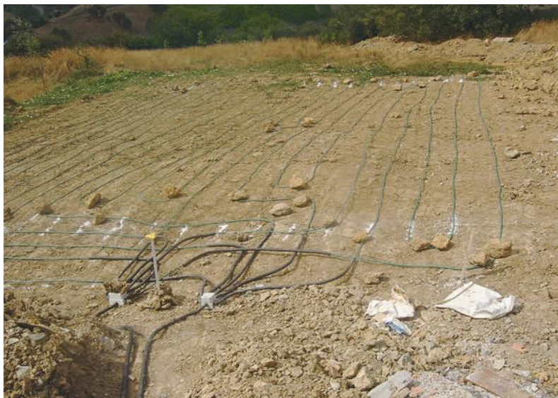
Sistema horizontaletan, hodiak jasotzen dute lurzoruan metatutako eguzki-energia. Eraikinean sartzeko, hodi biltzaile batzuekin elkartzen dira.
