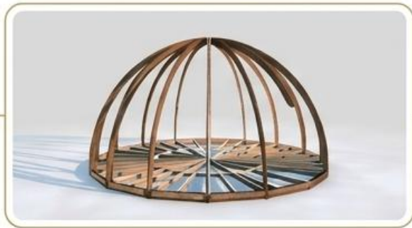
Tag 1: Bodenstruktur & Leimholz-Bögen
