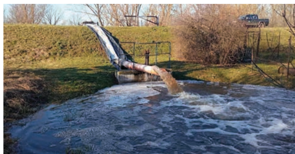
Szivattyúzás a Salamon-zugnál
