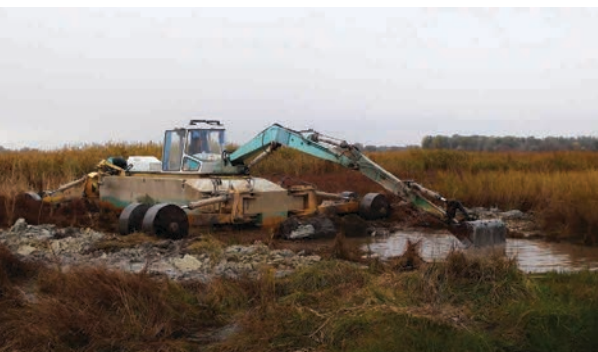
Szegély élőhelyek kialakítása „vízen járó” kotrógéppel
