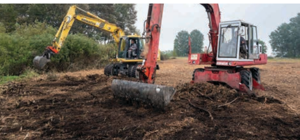
Erdészeti szárazúzózás és pásztamarózás után a mulcs eltávolítása következett
