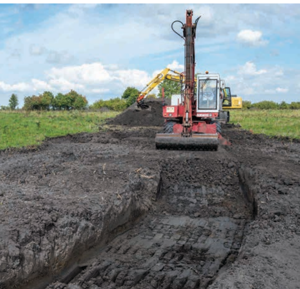
A földmunkák általában elengedhetetlen részét képezik a vizesélőhely-rekonstrukcióknak
