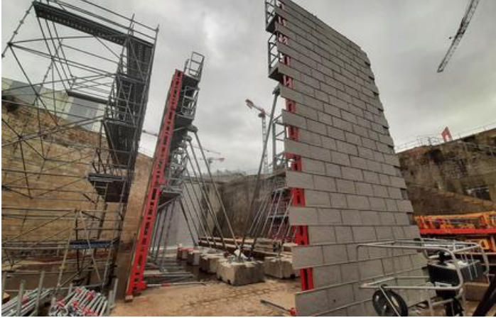
Le résultat du moulage pour reprendre l'apparence d'origine du Fort Boyard - ©Raphaël Barrou
