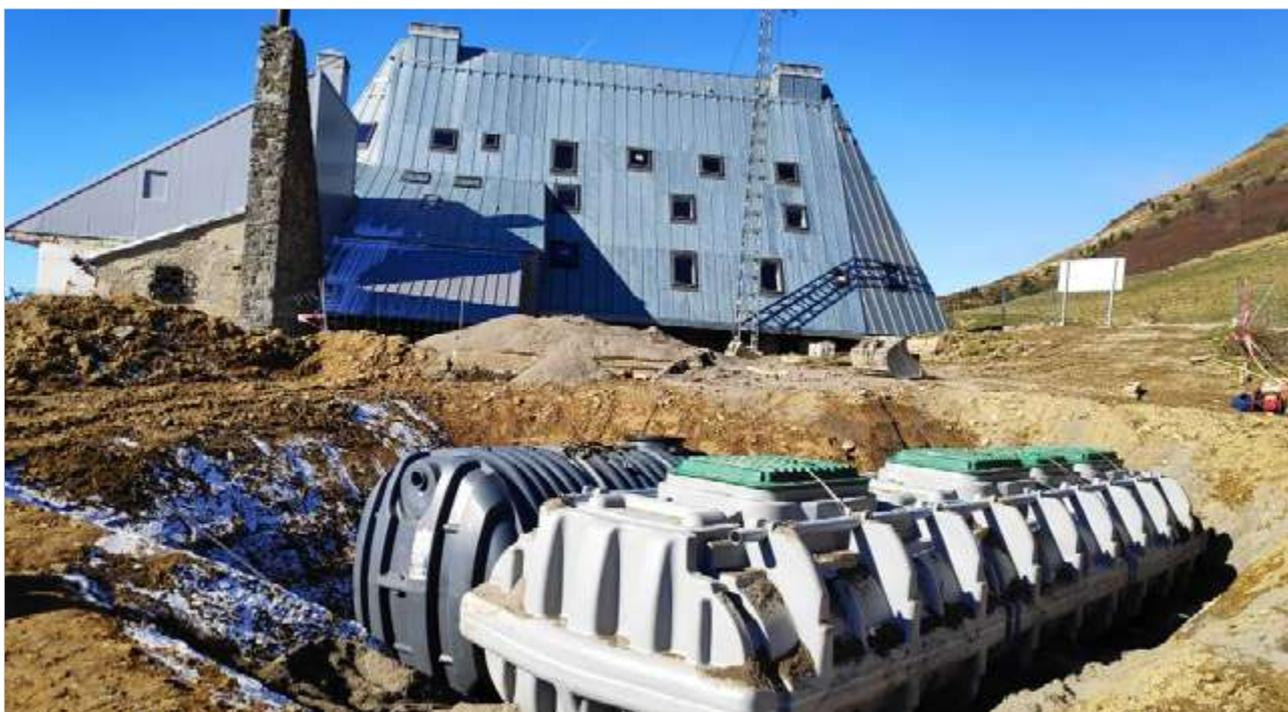
Instalação de um biofiltro Ecoflo num albergue de montanha.
