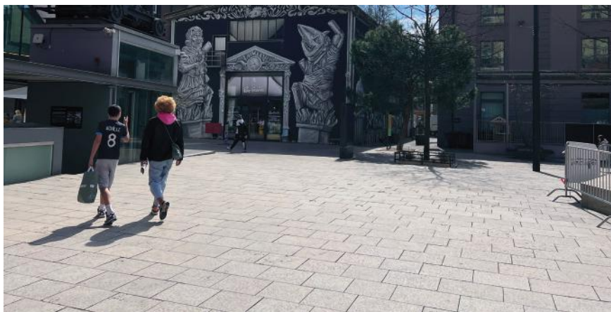
Le dallage en pierre naturelle scié-flammé; une valeur sûre pour les centres urbains: usages multiples, ambiance qualitative et entretien facilité. Lausanne, Esplanade du Flon.
