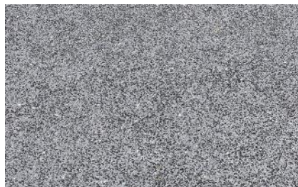
Béton coulé, agrégat standard, désactivé. Lausanne, Plateforme du Tram.
