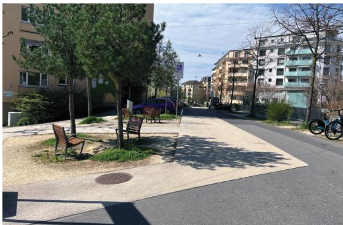
Revêtement bitumineux coloré clair. Lausanne, avenue des Jordils.
