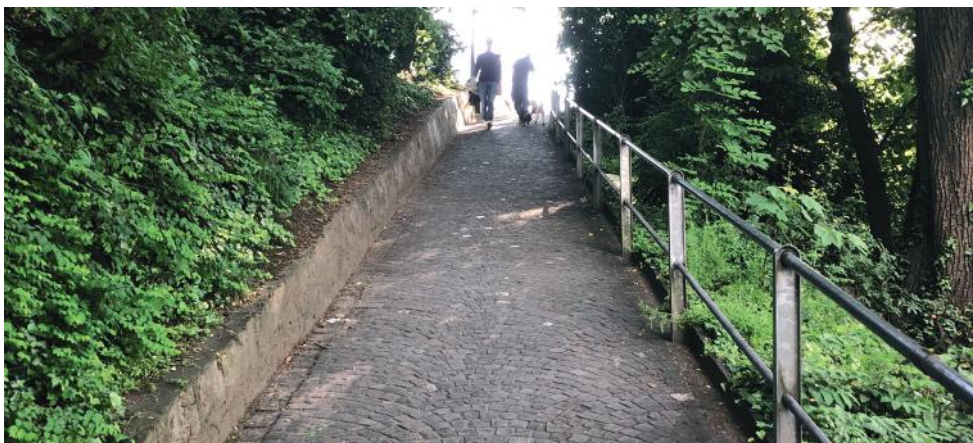
Pour les grimpées, le pavé grès offre une bonne accroche dans la pente, de plus il s'adapte bien aux courbes. Lausanne, grimpée de Chaudron Sud.
