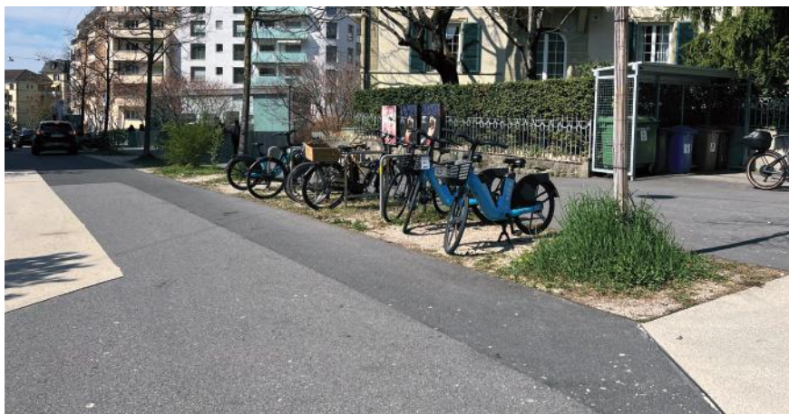
Gravier-gazon accueillant des arceaux-vélos. Lausanne, avenue des Jordils.
