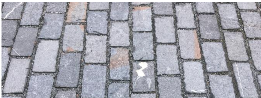
Boutisses grès, pose non liée, en ligne. Lausanne, avenue d'Echallens.
