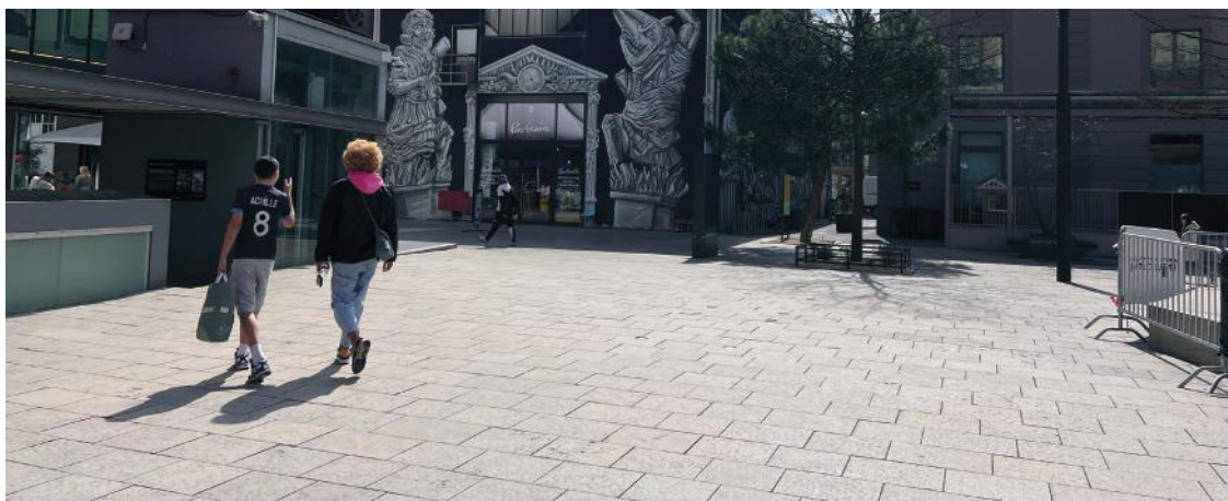
Dallage pierre naturelle (Calcaire de Villebois), scié, flammé, pose non liée. Lausanne, esplanade du Flon.
