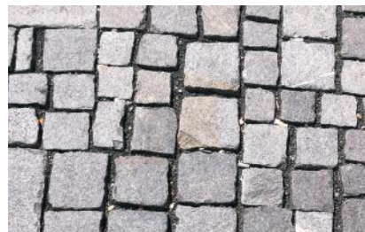
Mélange pavés et boutisses clivés, face à vue poncée-flammée. Pose non liée, en opus romain. Lausanne, Pré-du-Marché.
