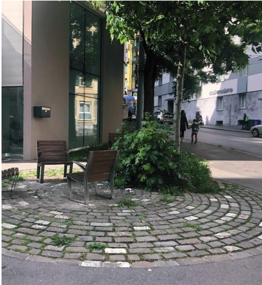
Les matérialités remplissent des fonctions : ici le pavage à joints engazonnés offre une surface à la fois praticable et semi-perméable au bénéfice d'un arbre. Lausanne, avenue Alexandre Vinet.
