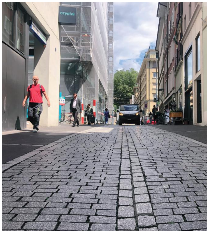
Pavage granit, faces latérales clivées, face supérieure sciée, flammée, pose non liée. Lausanne, Rue Chaucrau.
