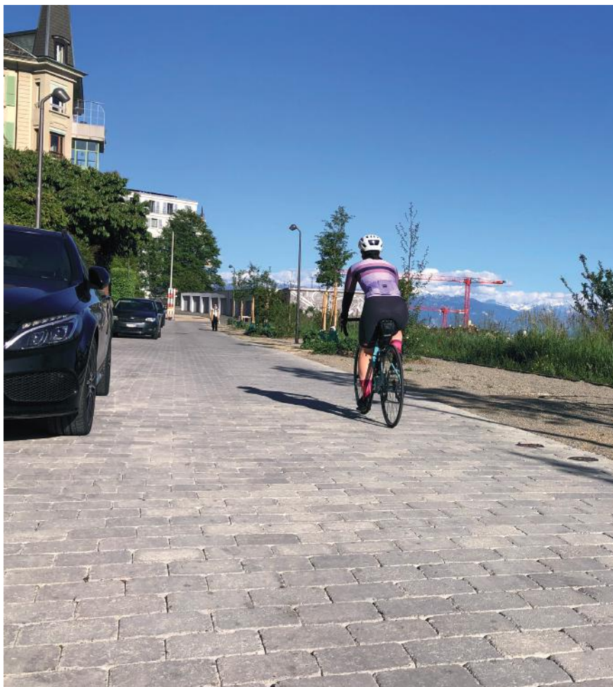
Pavage béton préfabriqué orthogonal standard. Lausanne, chemin de Villard.
