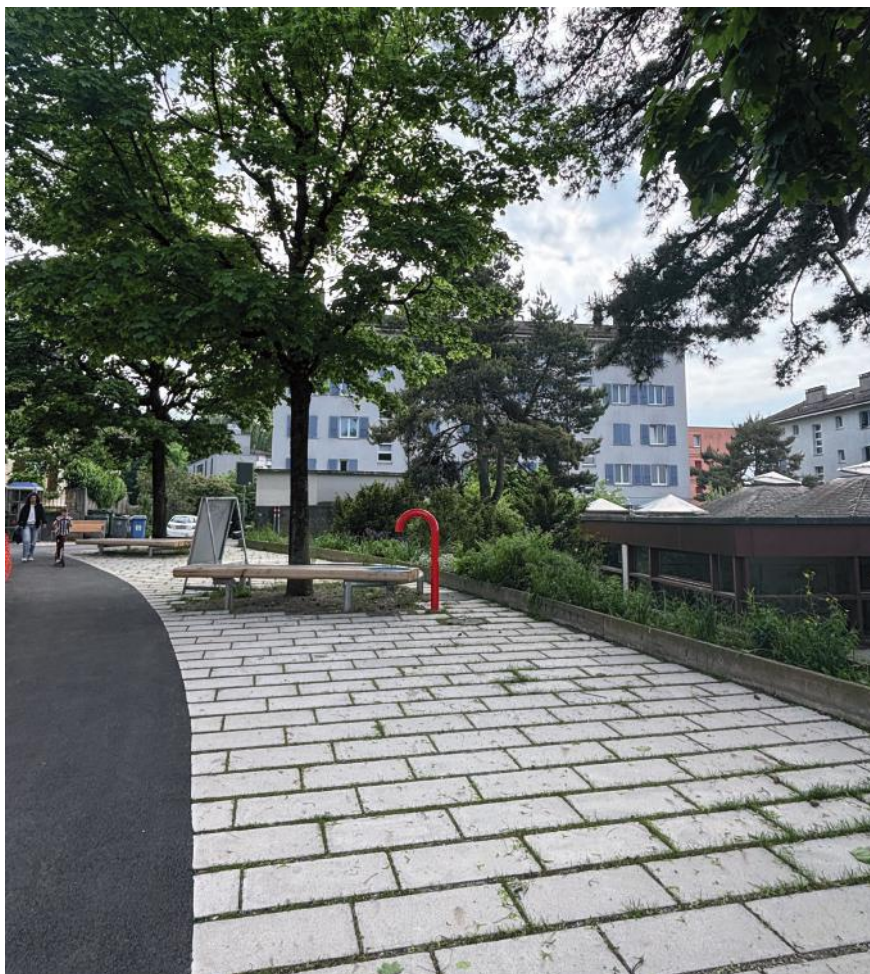
Dalles béton préfabriquées standard, joints larges enherbés. Lausanne, place Violette Tailens.
