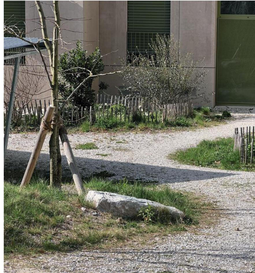
Les matérialités extensives tel que le gravier-gazon permettent d'associer végétation, perméabilité et cheminement dans l'optique d'une meilleure résilience climatique. Lausanne, Plaines-du-Loup.
