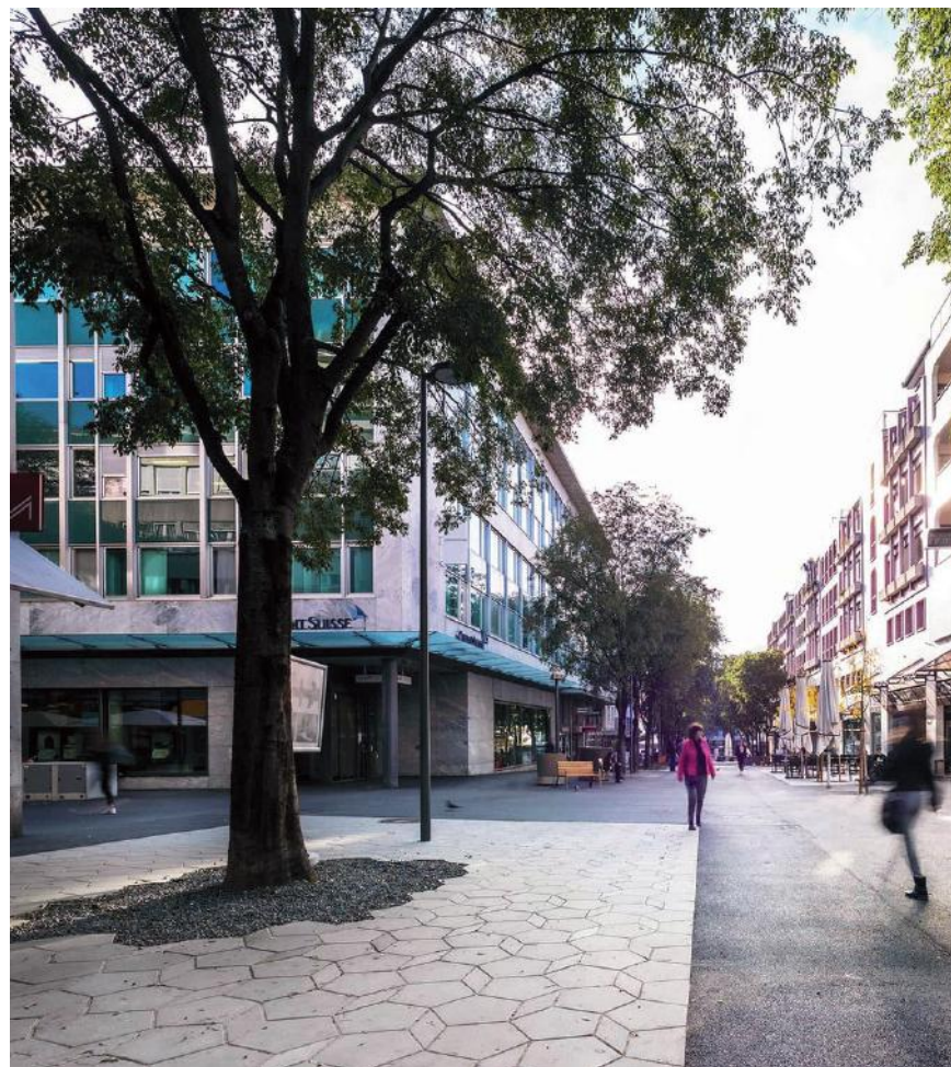
Dallage béton préfabriqué sur mesure, format polygonal. Sion, avenue du Midi © Copyright Olivier Maire / Studio 54 Sàrl.
