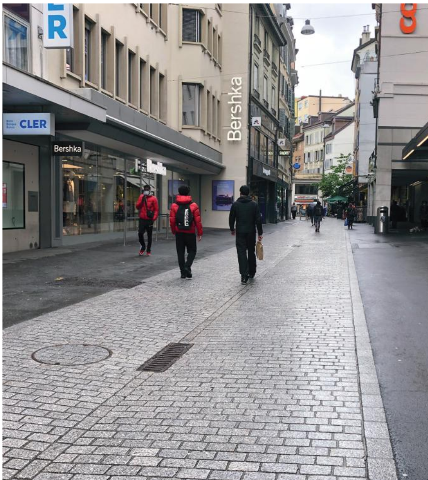
Pavage granit, faces latérales clivées, face supérieure sciée, flammée, pose liée. Lausanne, rue Saint-Laurent.
