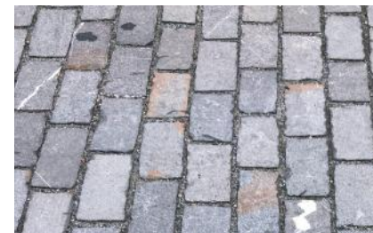
Boutisses clivées. Pose non liée, en lignes. Lausanne, avenue d'Echallens.
