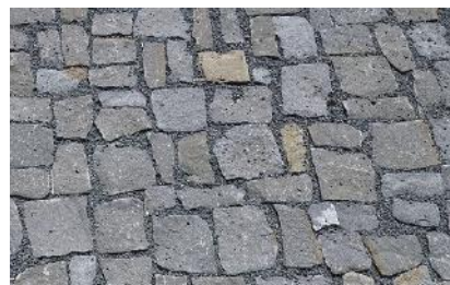
Pavés irréguliers clivés. Pose non liée, « à l'antique ». Ex. fréquent en Suisse alémanique
