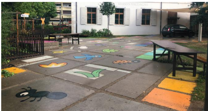
Dalles béton de réemploi. Meyrin, Maison Vaudagne.
