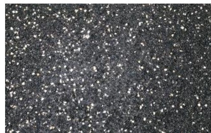
Revêtement bitumineux, clouté (de gravier blanc).
