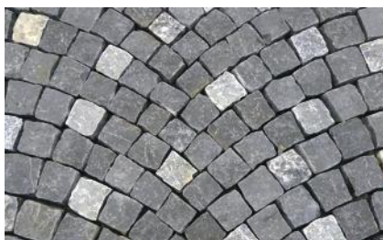
Pavés (avec 10% de veines de quartz) clivés. Pose non liée, en arc (traditionnelle). Lausanne, centre historique.
