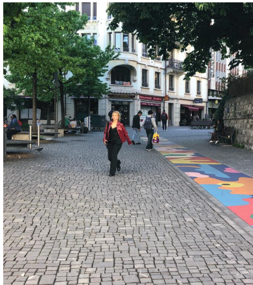
Pavés et boutisses grès, en mélange, pose non liée, à l'antique, finition de surface poncé-flammé. Lausanne, rue Pré-du-Marché.
