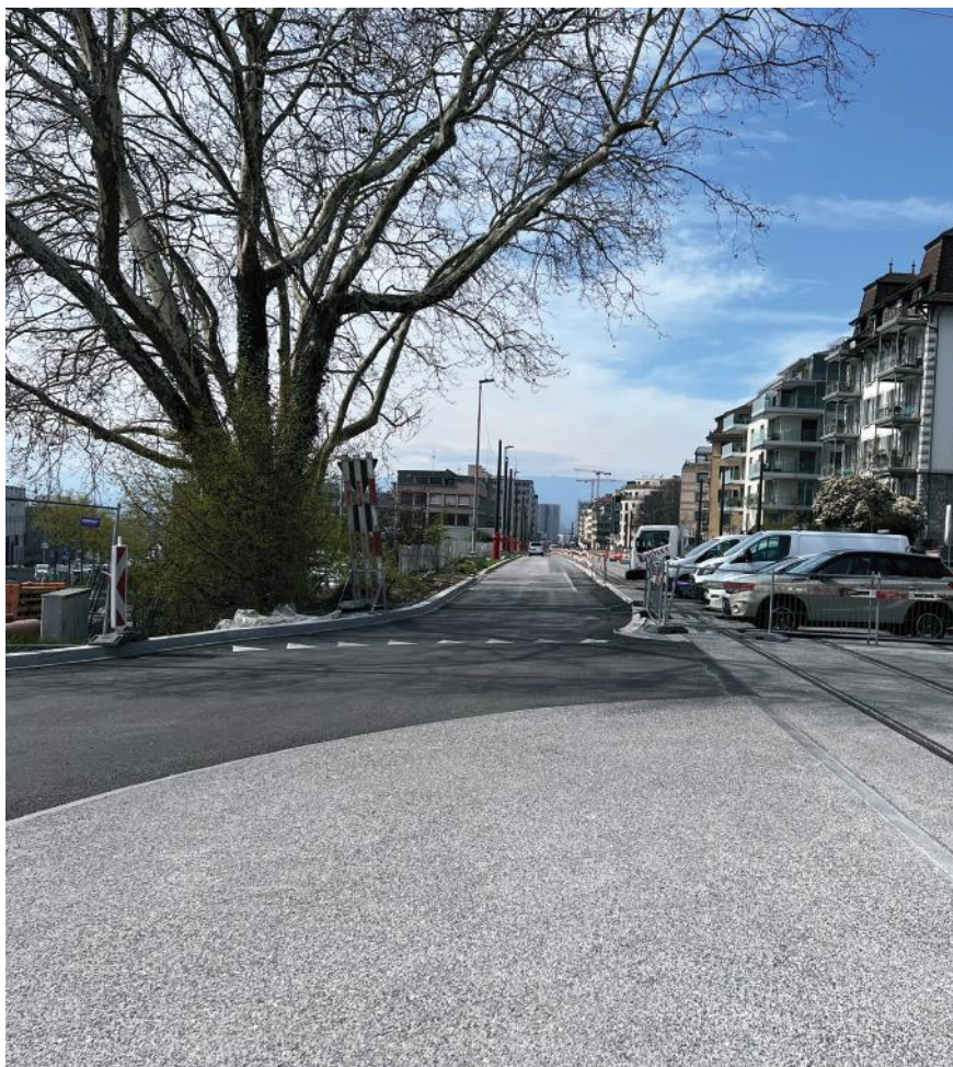
Béton coulé désactivé, agrégat mixte, plateforme du tram. Lausanne, rue de Genève.
