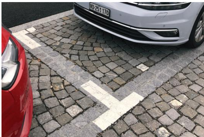
Places de parc en pavage grès pose non liée avec cadre en pose liée.
