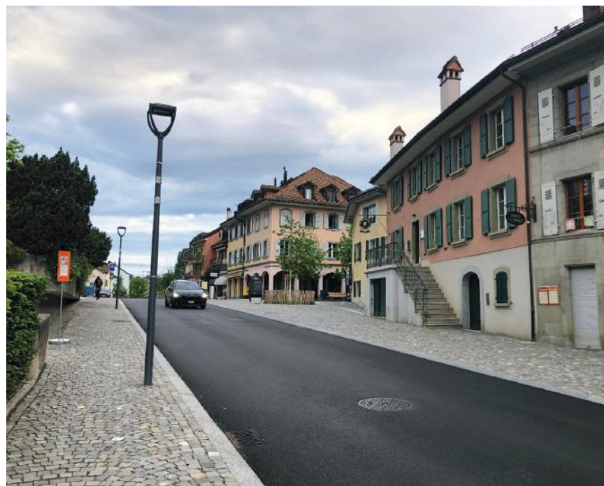
Fig. 4 – Les matérialités indiquent les usages. Exemple de l'avenue Samson Reymondin à Pully : surfaces piétonnes en pavés de pierre naturelle clivés, pose non liée et voie de circulation en revêtement bitumineux.
