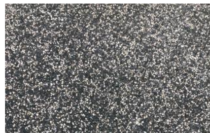
Revêtement bitumineux, chiné-poncé.
