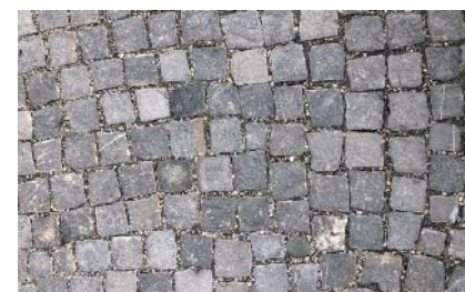
Pavés clivés. Pose non liée, « à l'antique ». Lausanne, Malley
