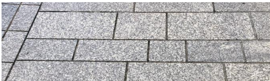
Dallage pierre naturelle, scié, flammé. Pose liée. Granit / gneiss. Lausanne, rue Haldimand.
