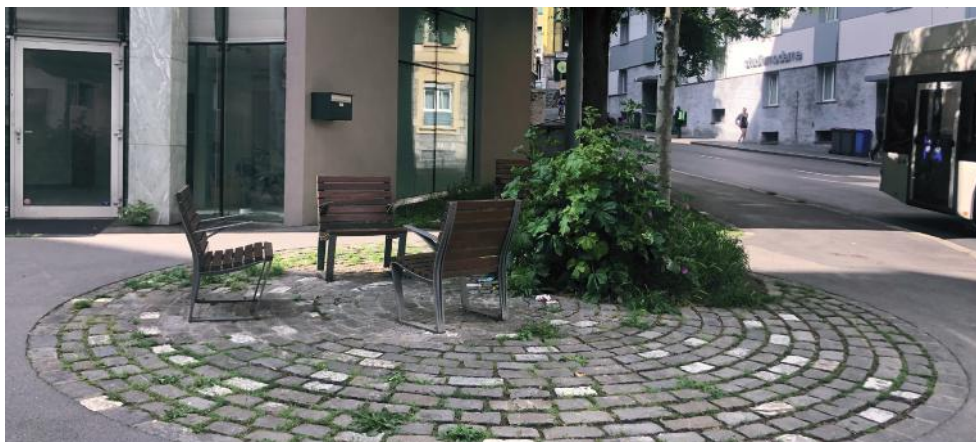
Entourage d'arbre en boutisses de Guber, pose non liée, joints engazonnés. Lausanne, avenue Alexandre Vinet.
