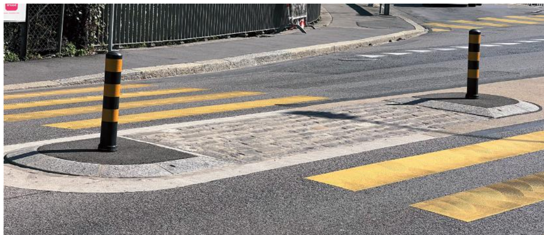
Îlot de passage piétons en boutisses, pose liée.
