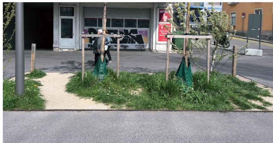
Gravier-gazon et stabilisé naturel ; les surfaces les moins piétinées se verdissent naturellement. Lausanne, avenue d'Echallens.
