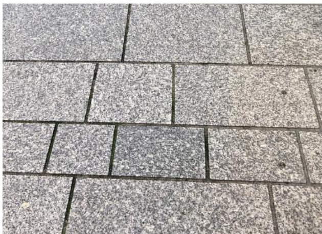
Dallage en pierre naturelle (granit / gneiss), scié, flammé, pose liée. Lausanne, rue Haldimand.
