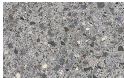
Béton coulé, agrégat mixte (standard + Jura), désactivé. Versoix, Route de Suisse.
