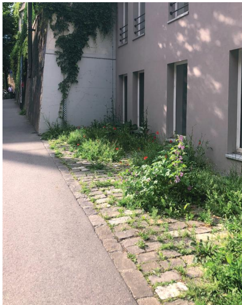
Pavage en boutisses de Guber, pose non liée, joints enherbés. Lausanne, avenue Alexandre Vinet.
