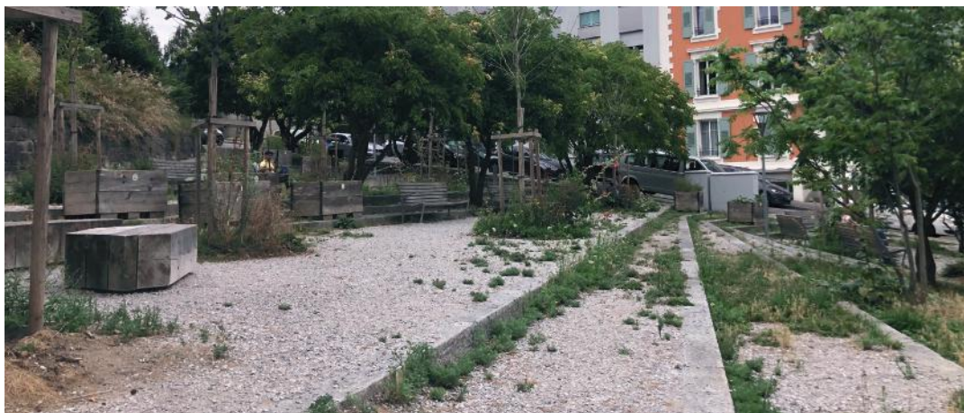
Gras d'Enney 0/16. Lausanne, place Liliane Bergier. Le stabilisé permet une colonisation par de la végétation rudérale.
