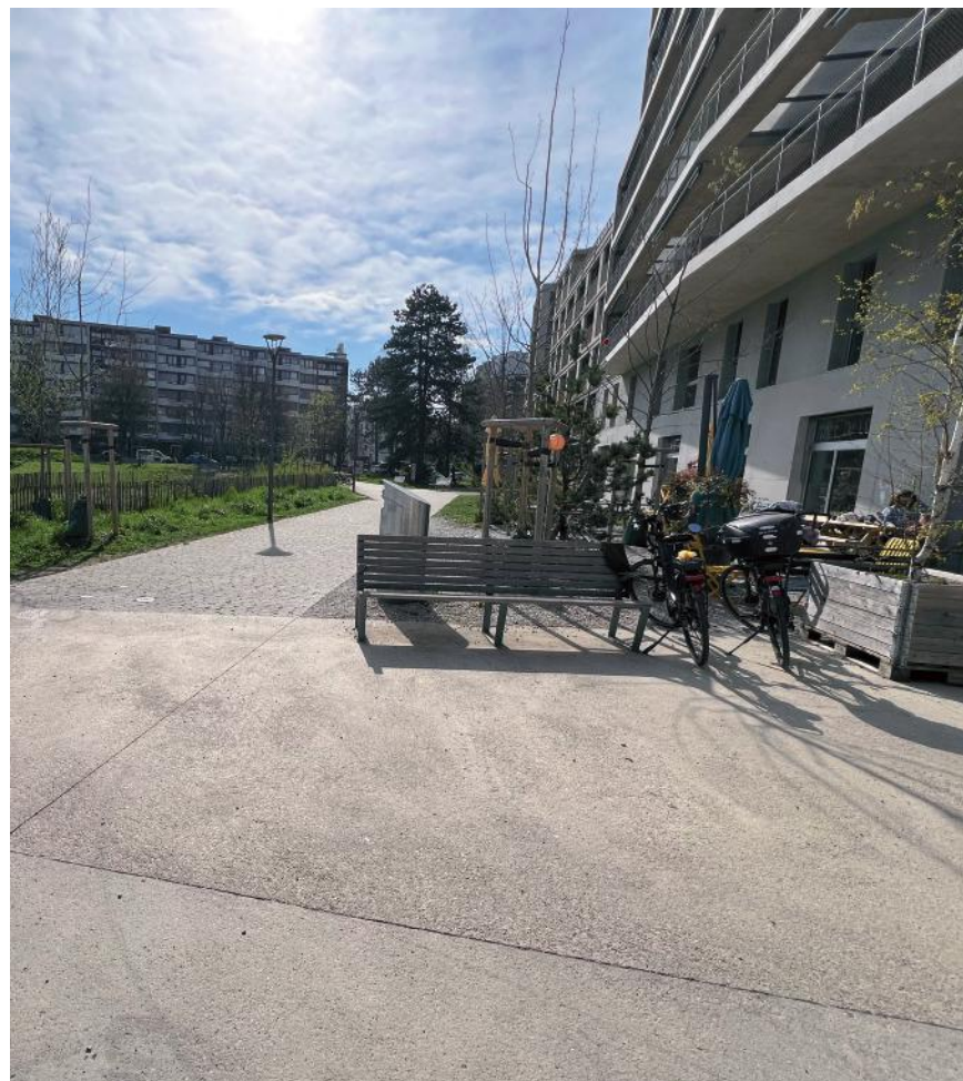
Béton coulé sablé, agrégat standard. Lausanne, Plaines-du-Loup.
