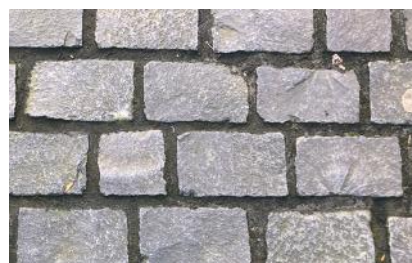
Boutisses clivées. Pose liée, en lignes. Lausanne, îlots de passages piétons / aires de stationnement motocycles
