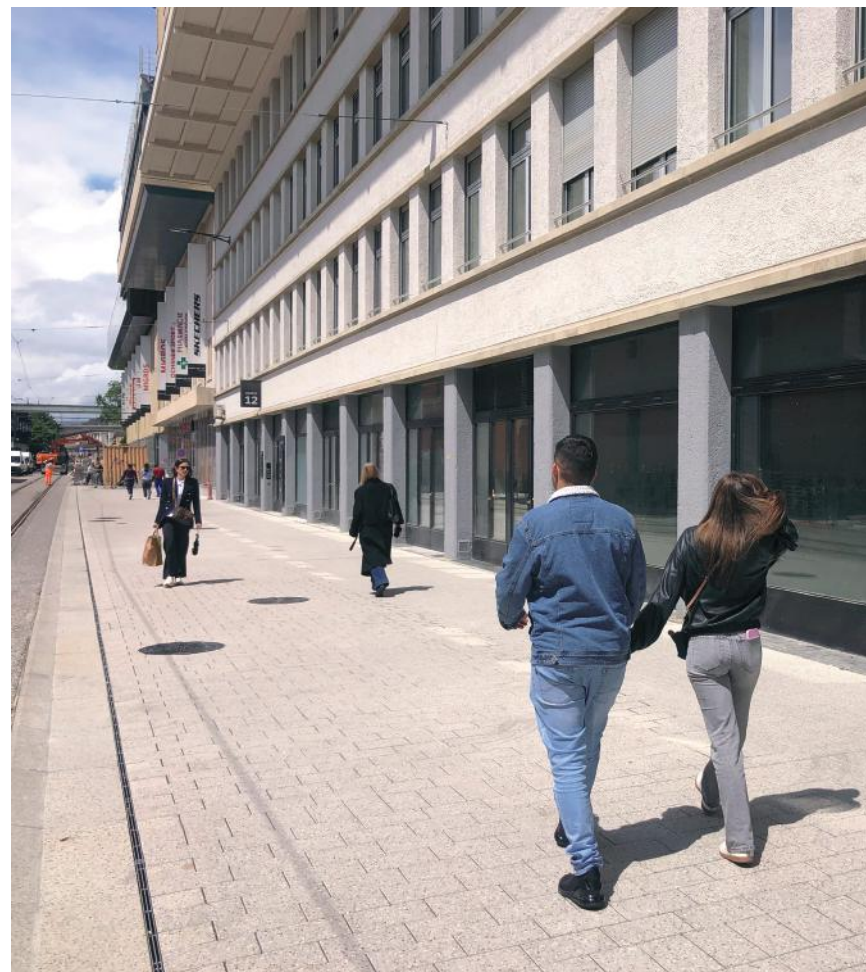
Pavage béton préfabriqué orthogonal semi-standard. Lausanne, rue de Genève.
