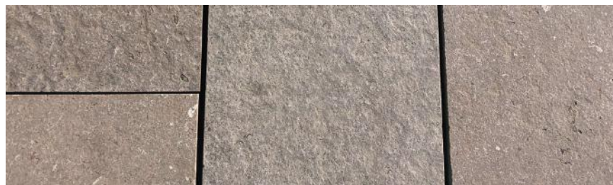
Dallage pierre naturelle, scié, flammé. Pose non liée. Calcaire de Villebois. Lausanne, Esplanade du Flon.
