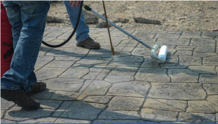
Aplicación de sellador en una superficie de concreto estampado mediante el método de "pulverización y rodillado posterior"
