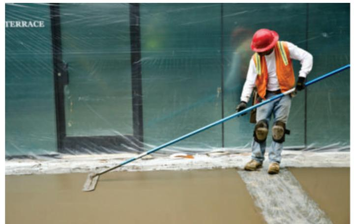
**Fig. 1: Uso de un Fresno plano después de el primer aplanado del concreto y previo a cualquier sangrado en tanto se prepara la aplicación de un retardante superficial. (tomado de CCS-5 (16)<sup>3</sup>)**
