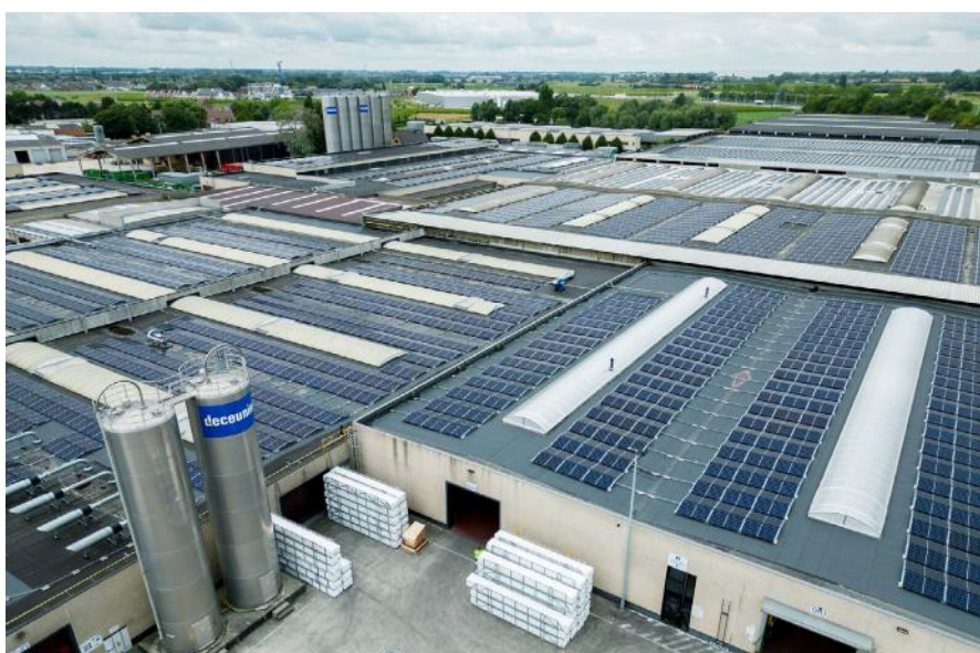
Planta de DECEUNINCK en DIKSMUIDE (Bélgica), con capacidad para reciclar 45.000 toneladas de PVC al año.
