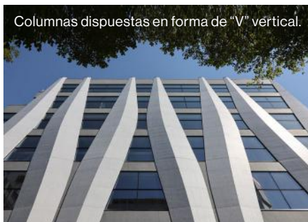
La arquitectura del edificio IKEUCHI GATE se caracteriza por su icónica estructura portante.
