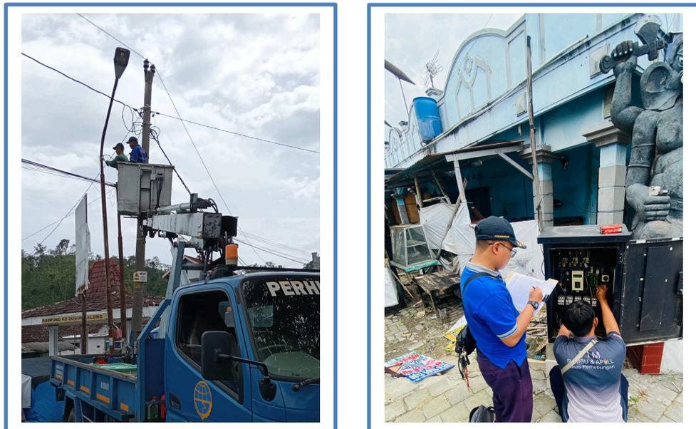
Gambar 6. 2 Kegiatan Perbaikan Lampu PJU
