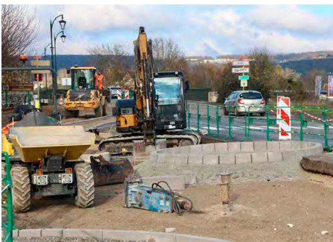
Les travaux devraient être terminés fin décembre. © l'Hebdo du Vendredi
