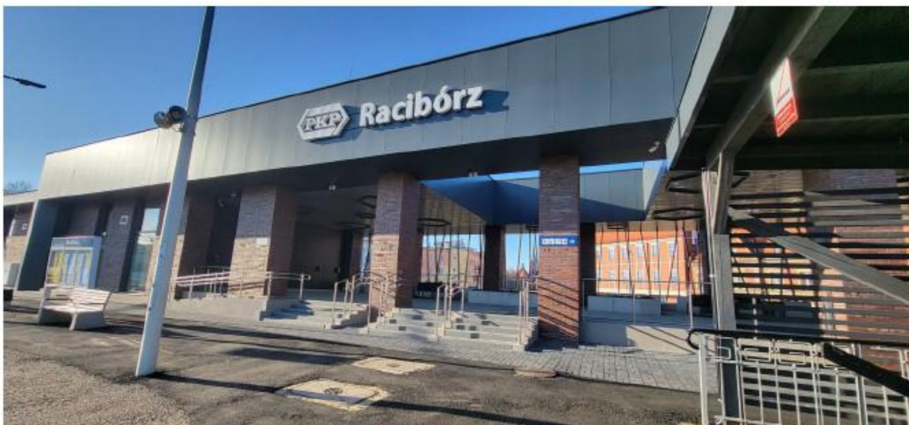
ELEWACJA OD STRONY PERONÓW
