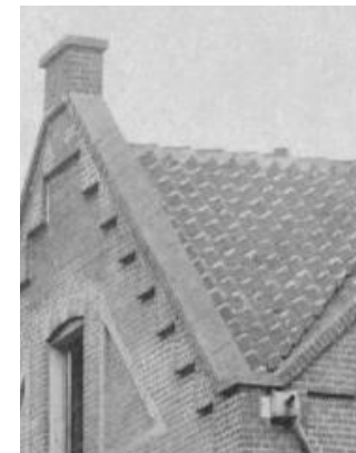
De zinken afdekkingen en een oude foto met afgesmeerde rollaag
