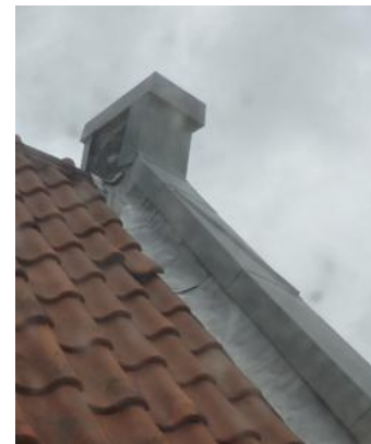
De zinken afdekkingen en een oude foto met afgesmeerde rollaag
