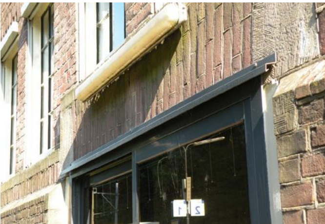
Het fijnwerk van de natuursteen (zandsteen?) lateien
