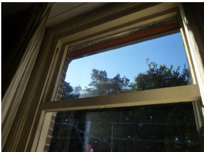
Het nog aanwezige schuifmechanisme van de schuiframen
