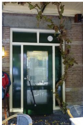
De "eigentijdse" pui met deur naar het perron in de achtergevel
