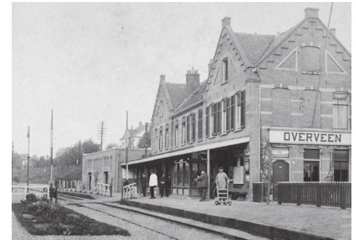
Het uitgebreide emplacement met op de achtergrond de goederenloods (1917)
