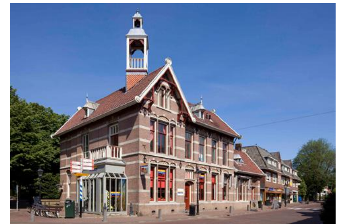
Het nieuwe postkantoor (1907)
