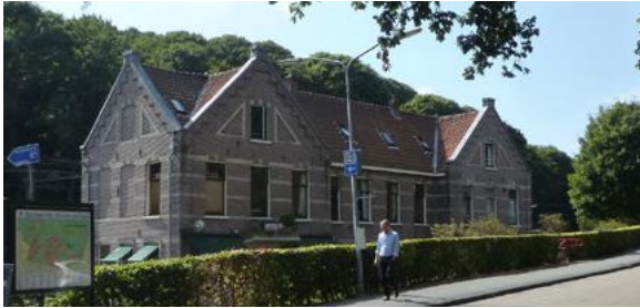
1. Een stationsgebouw uit 1881
