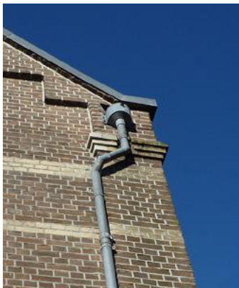
De verkeerd geplaatste hemelwaterafvoer en de ontworpen oplossing
