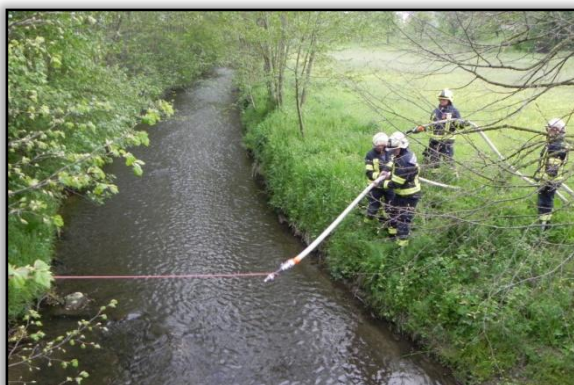
Verlegen des luftgefüllten Schlauches
