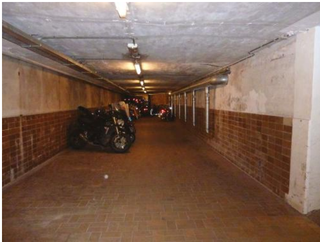
Perrontunnel 2015. Een deel van de oorspronkelijke stenen vloer en de tegelbekleding op de wanden is nog aanwezig.
