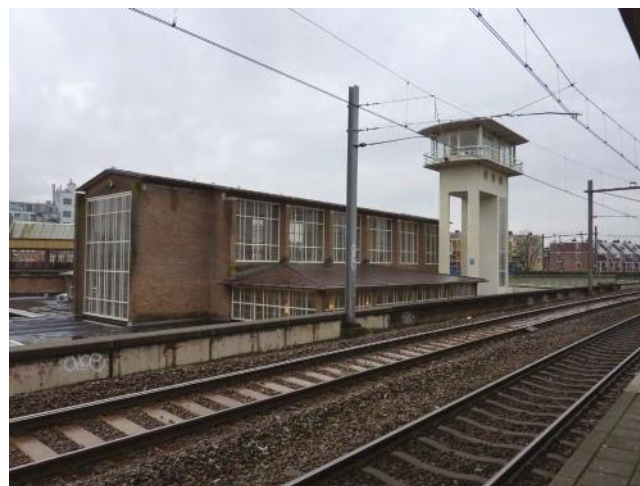
Oostgevel, gezien vanaf het spoor naar Amersfoort
