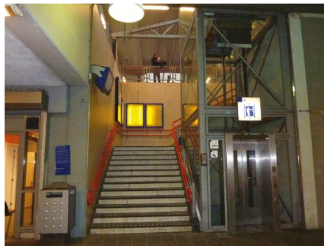
Perrontoeegang in de onderdoorgang naar de Celebesstraat, aangelegd bij de verbouwing in 1998-2000.
