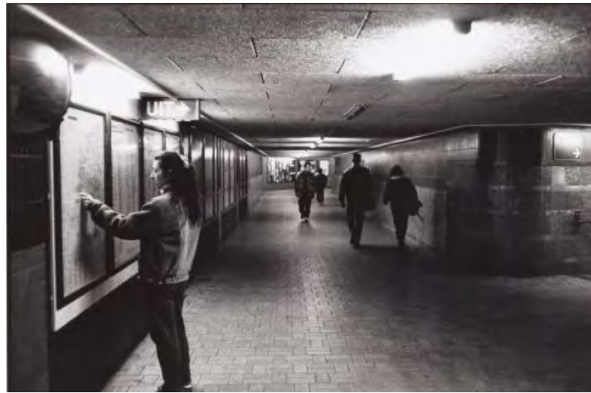
Interieur van de boventunnel, 1990. [SAA]
