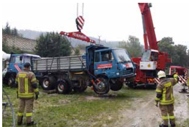
13. September - Kranführerweiterbildung Vöcklabruck
