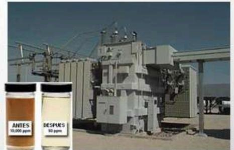
Nuestro servicio ofrece un proceso de Purificado al Aceite del transformador a través de una máquina especial presurizada al vacío que permite recircular el aceite desde el transformador hacia la máquina, pasándolo por un calentador que le retira humedad, una cámara de vacío que retira gases y por último un filtro de micrones que le retira partículas en suspensión, para luego regresarlo limpio hacia el transformador.
