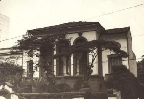
Fachada da filial Ibeu da Rua Senador Vergueiro, no bairro do Flamengo.
