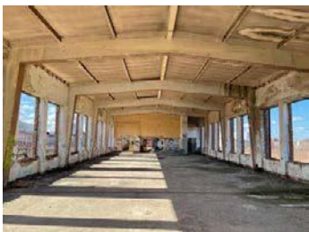
Die ehemalige Werkhalle des Betriebs 13 wird zur Gastwirtschaft umgebaut
