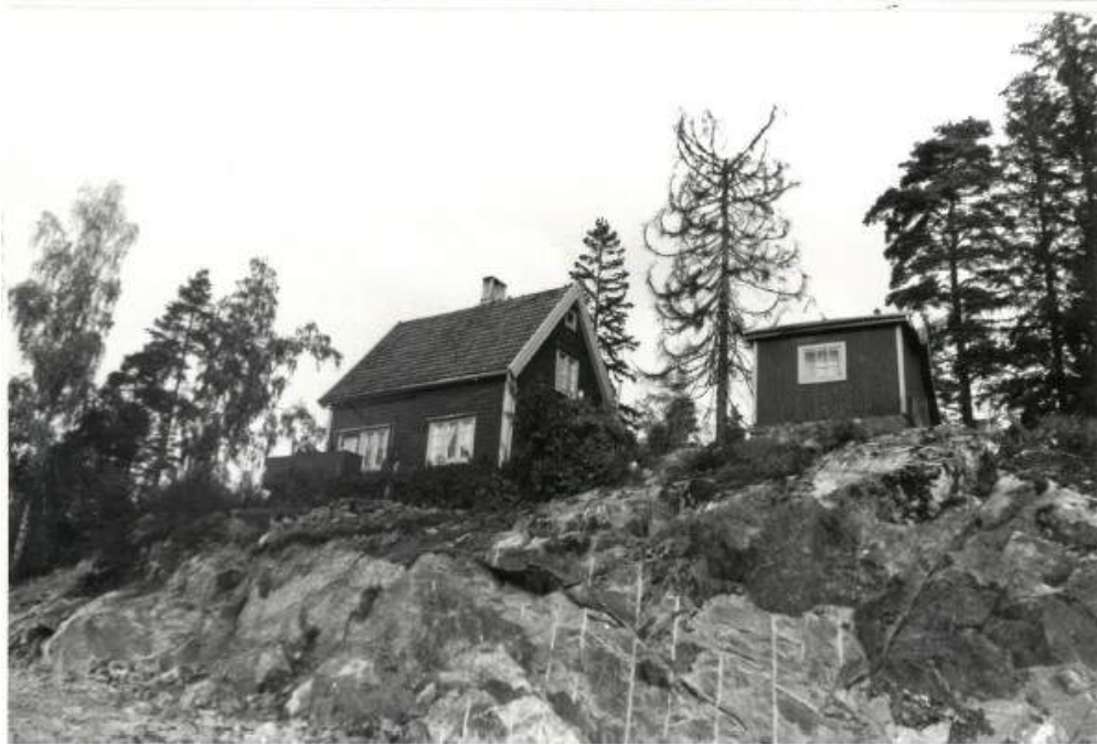
Bolighuset på eiendommen Toppen som ble brent ned i februar 1981. Hytta ligger til høyre. Bildet er tatt mot nordvest fra den nylig anlagte traséen til Ravnåsveien. Foto: Byantikvaren i Oslo, oktober 1980
