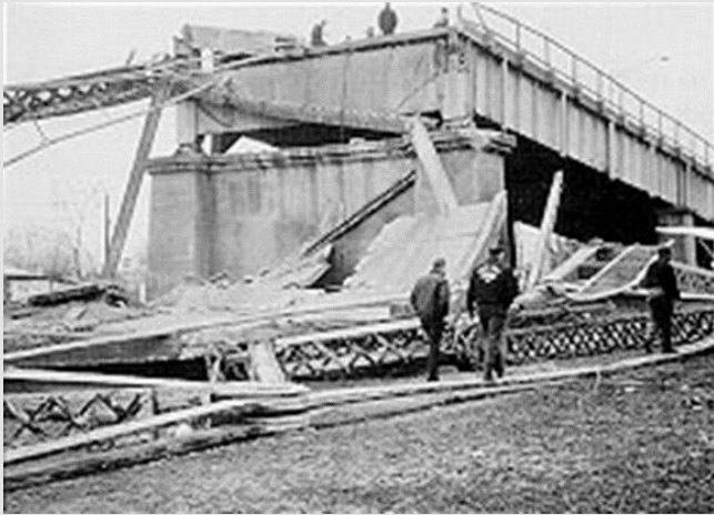
Bağlantı elemanında döküm kaynaklı kalıntı gerilmeler nedeniyle yıkılan Silver köprüsü (Ohio/Amerika) (Totten et al. 2009)
