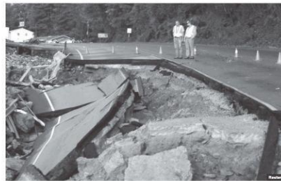
(Hình REUTERS: Nhân viên cấp cứu khảo sát một đoạn lớn của xa lộ 105 bị đổ lút gây ra trong bão Helene, ngoại ô Boone, North Carolina, 27/9/2024.)
