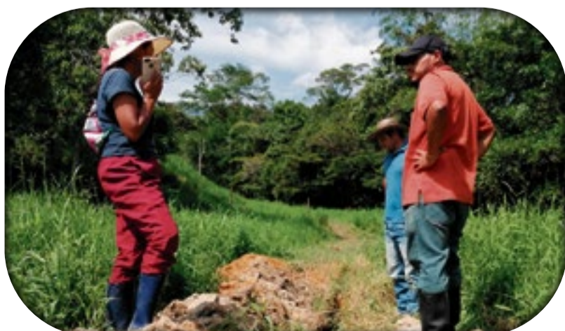
Construcción de zanja par tubería, JAC Peñoles.
