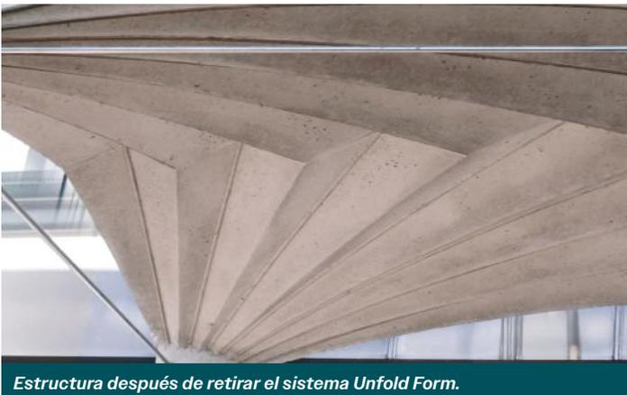
Estructura después de retirar el sistema Unfold Form.
