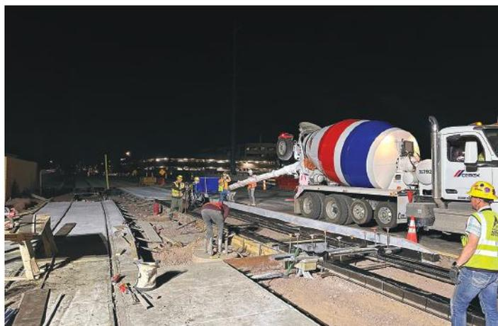
Colocación de losas de vía de concreto reforzado con fibras para la extensión del tren ligero de Phoenix.
