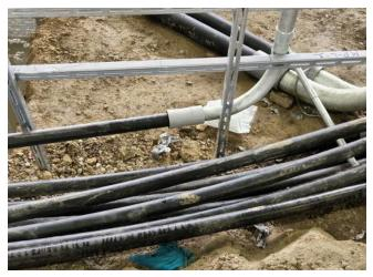
FIGURE 5-05 Non PVC below grade conduit.
