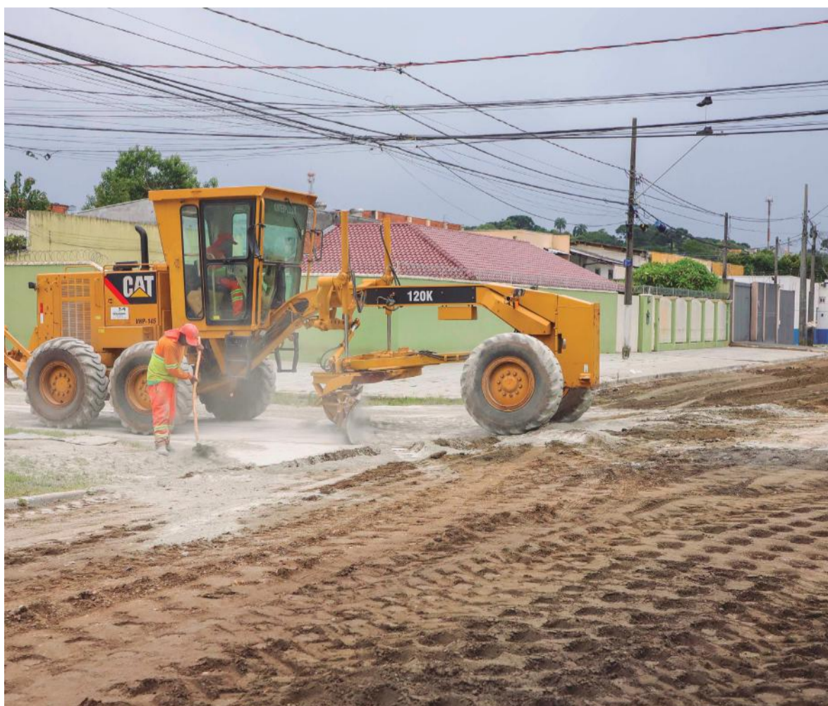
Obras de reciclagem do pavimento para melhorar a mobilidade na região
