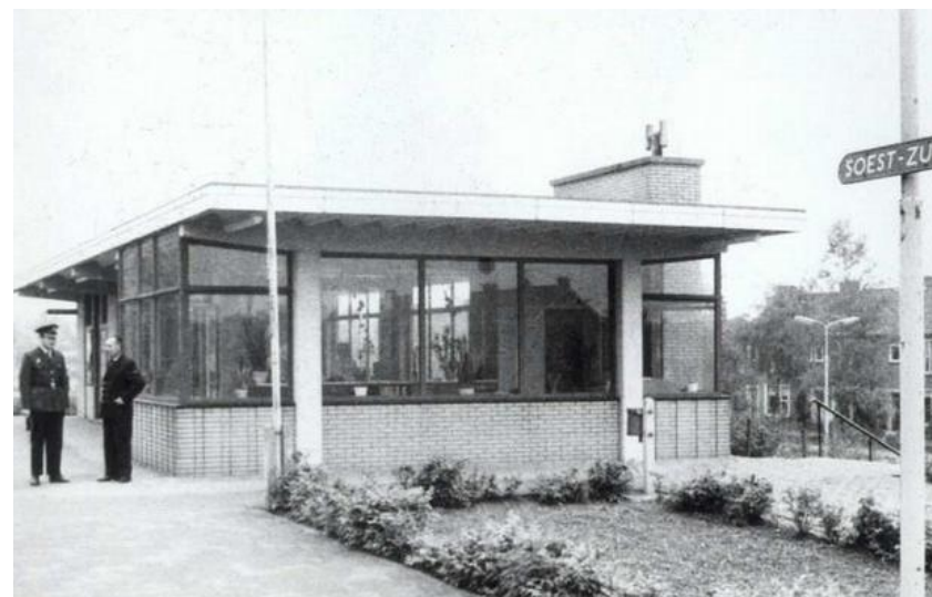
Afb. 5.5 Een kopgevel van Soest Zuid; door de afwerking met een daklijst vallen rondingen van de kwaaitaalbalken uit het zicht. Foto Gemeentearchief Soest, 1965.
