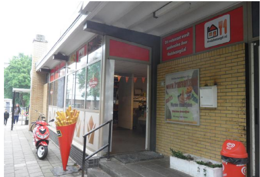
Afb. 5.16 De voorgevel, met de hoofdentree in de zijwand van de 'nieuwe' uitbouw. Op de voorgrond een resterend deel van de toegangstrap.
