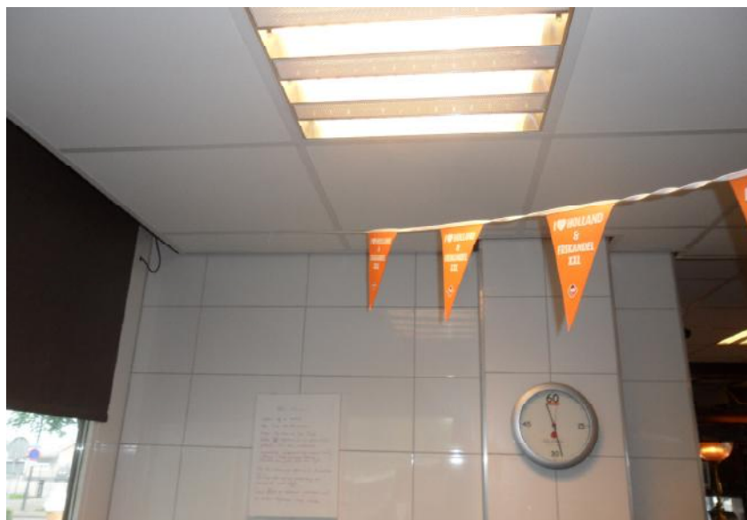
Afb. 5.23 Achter de klok de vooruitspringende, betegelde paal van het derde betonportaal. De paal is de oorspronkelijke locatie van de buitengevel, nu links zichtbaar.
