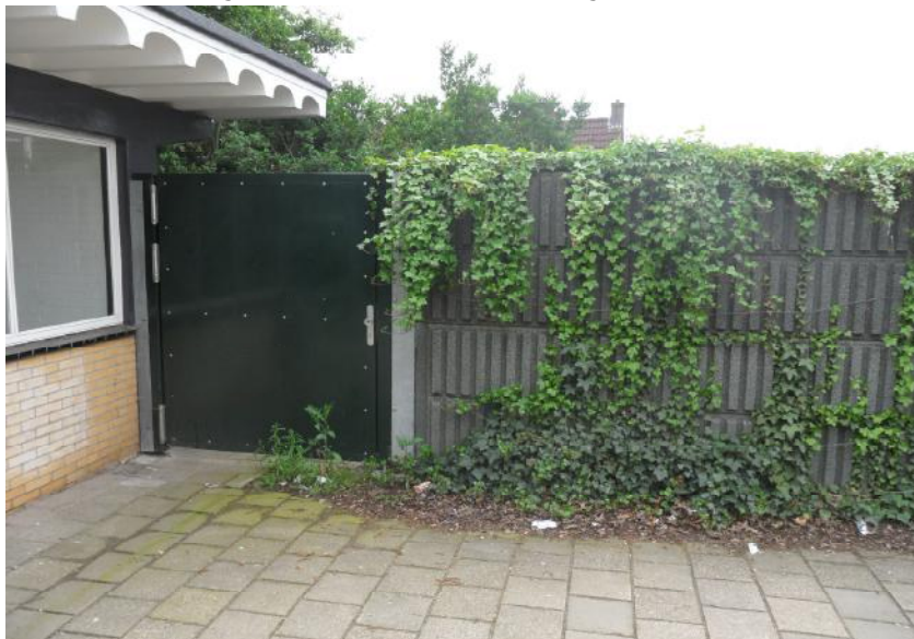
Afb. 4.21 Verwilderende beplanting en zwerfvuil naast het wachtgebouw op perron 2.
