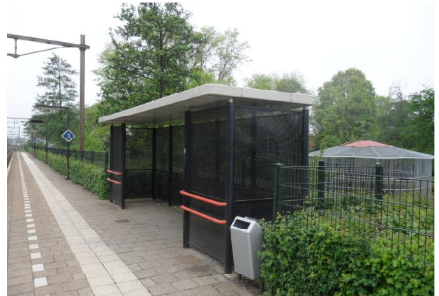
Afb. 4.14 De abri met staalgaaswanden op perron 1.
