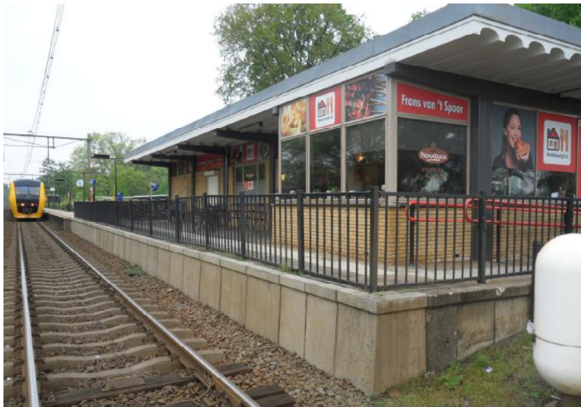
Afb. 4.12 Perron 1 in de actuele situatie, gezien vanaf de spoorwegkruising.
