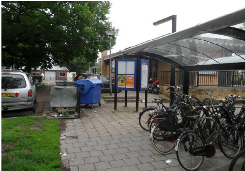
Afb. 4.16 Verrommeling bij de voorzijde van het stationsgebouw.
