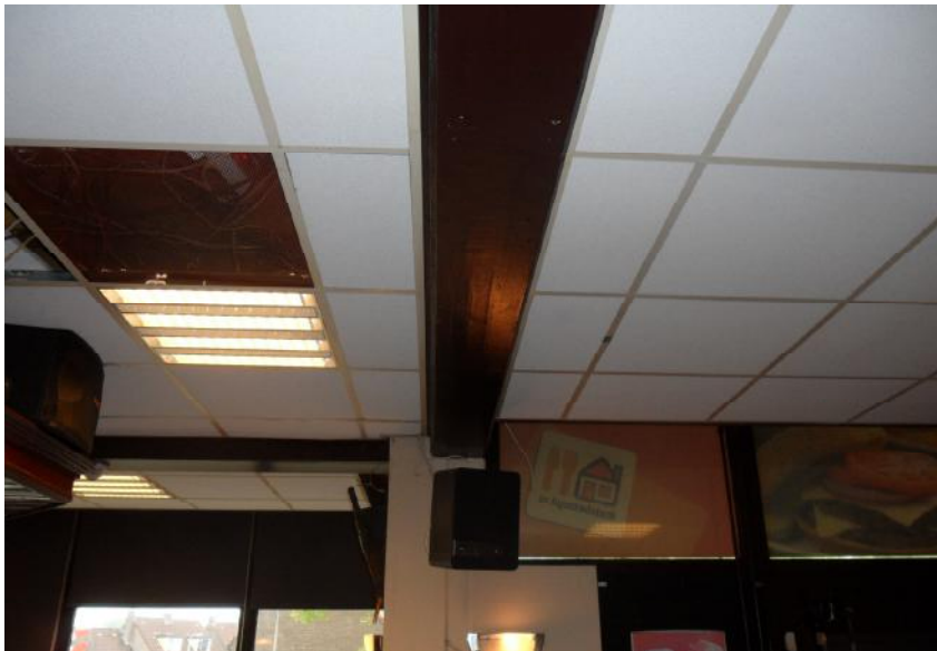
Afb. 5.27 Met hout afgetimmerde balk van het tweede betonportaal.
